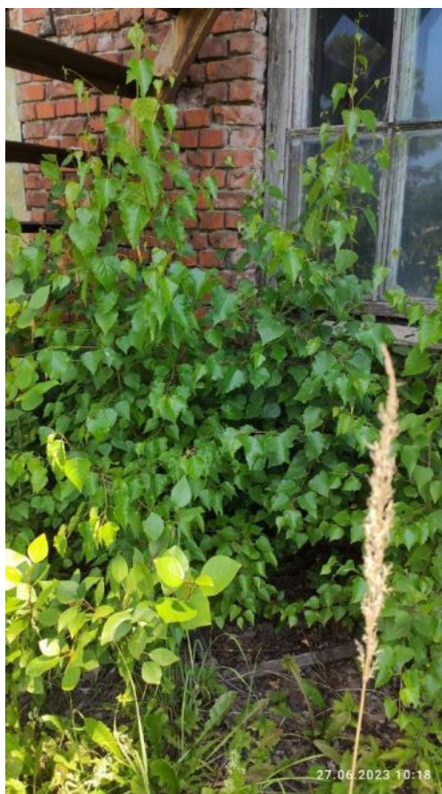
Рис. 24. Рост растительности на месте отмостки фундамента
