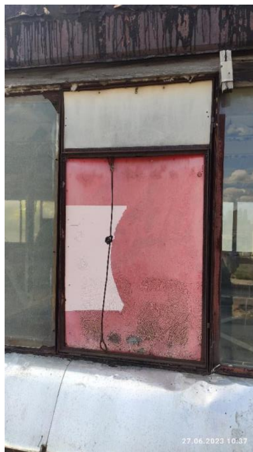
Рис. 120-121. Износ уплотнительных прокладок, трещины на стеклах, коррозия профилей
