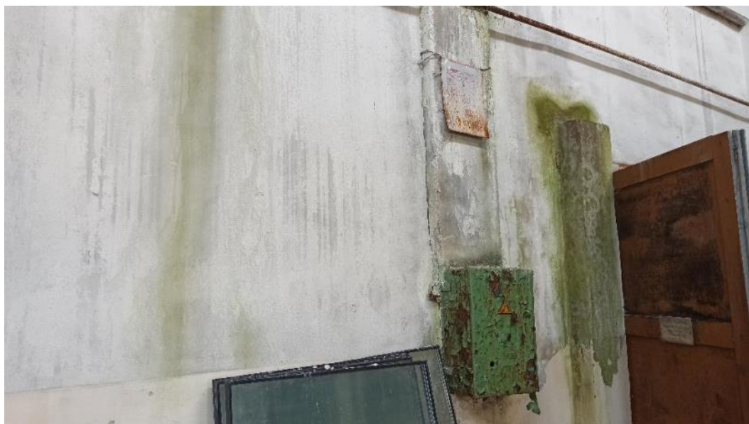
Рис. 147. Замачивание отделочного покрытия, биоповреждение стен
