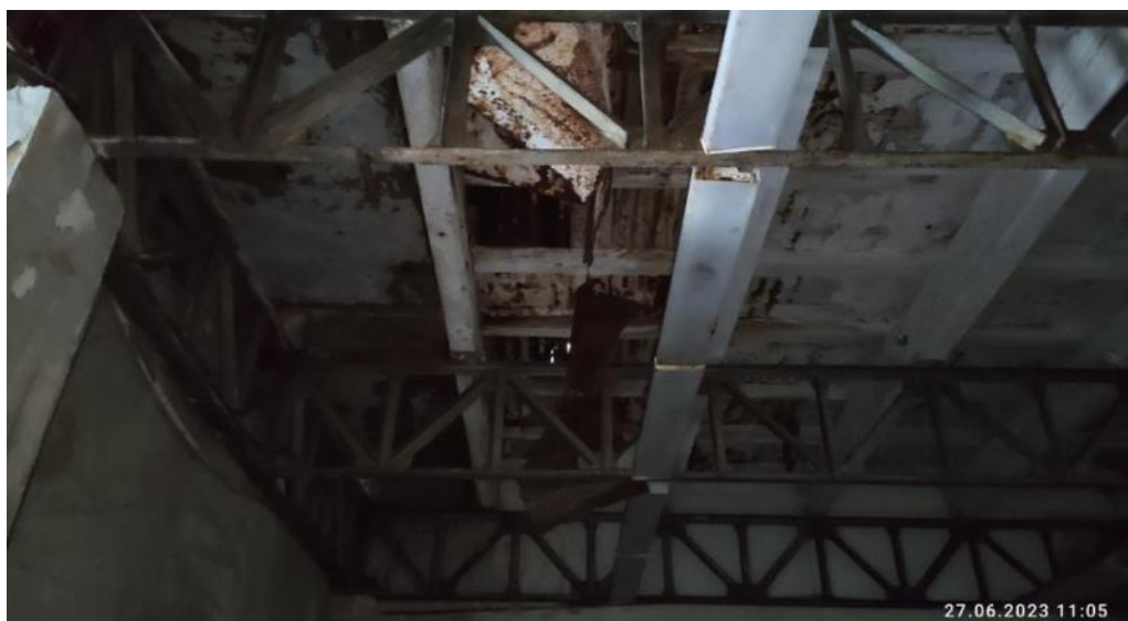
Рис. 79. Коррозия стержней металлических ферм
