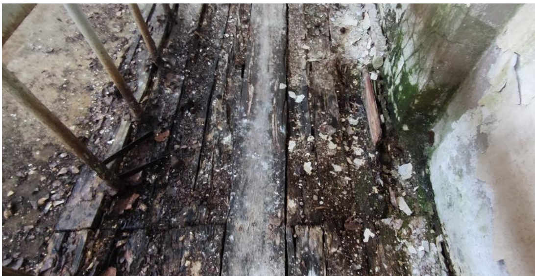
Рис. 114. Износ деревянных полов
