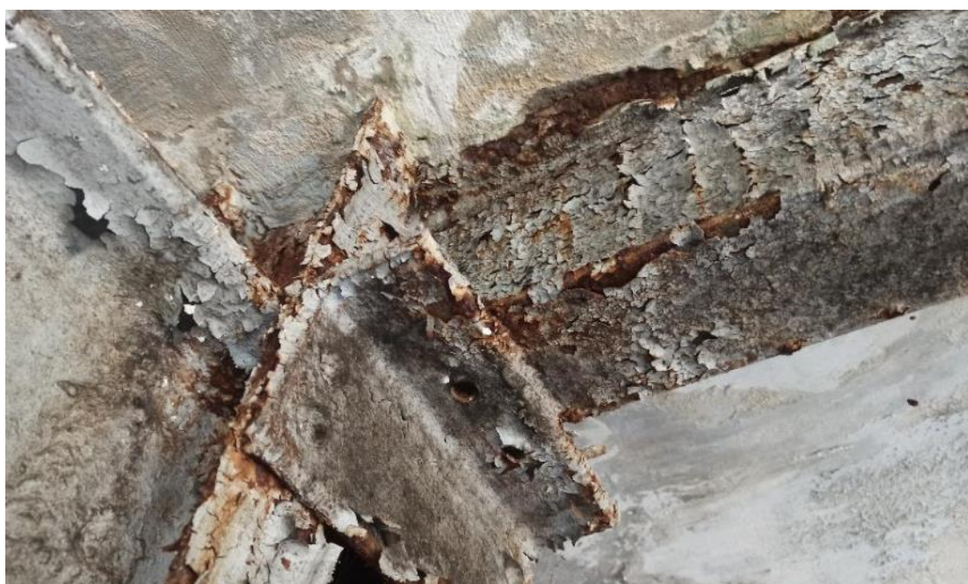
Рис. 82. Коррозия металлических балок покрытий
