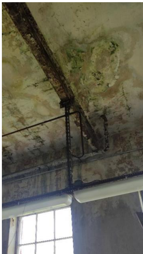
Рис. 155. Замачивание и биоповреждение отделочного покрытия
