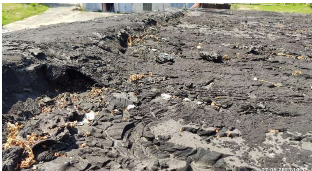
Рис. 99. Трещины и разрывы на кровельном покрытии, вздутие и отслоение от основания
