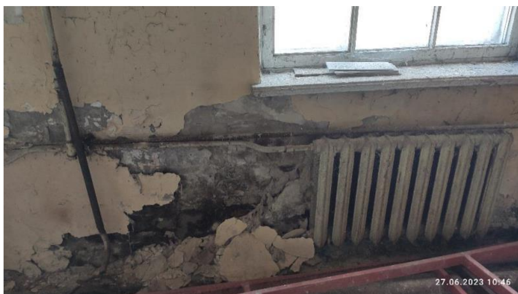
Рис. 168. Значительное поражение коррозией радиаторов и труб отопления
