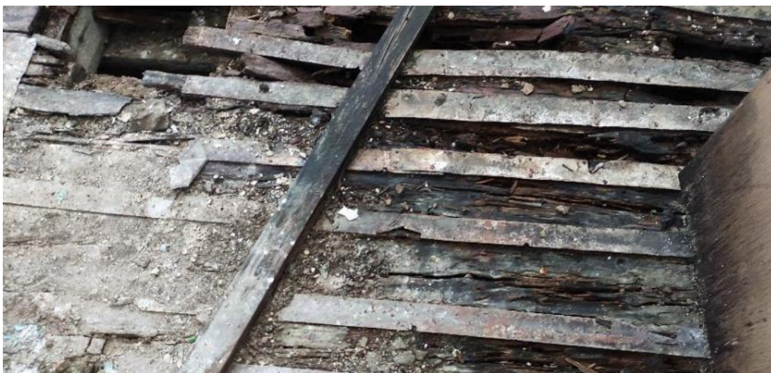
Рис. 116. Биоповреждение конструкций полов
