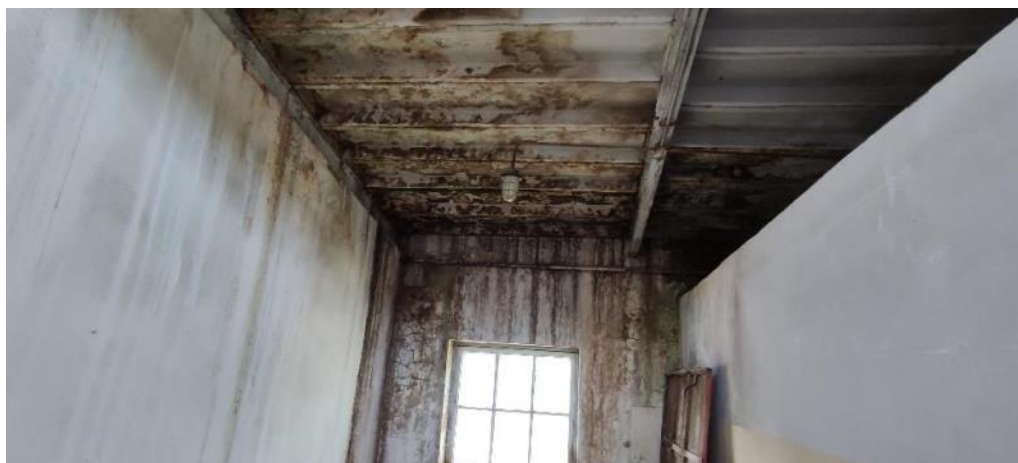
Рис. 71. Сплошная течь кровли, участки замачивания на нижней части плит покрытия
