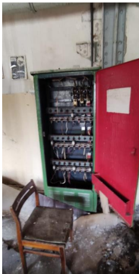
Рис. 161-162. Износ системы электроснабжения. Состояние – аварийное
