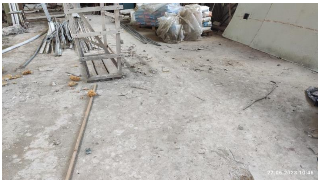
Рис. 111. Сколы, трещины в полах, стертость материала в ходовых местах
