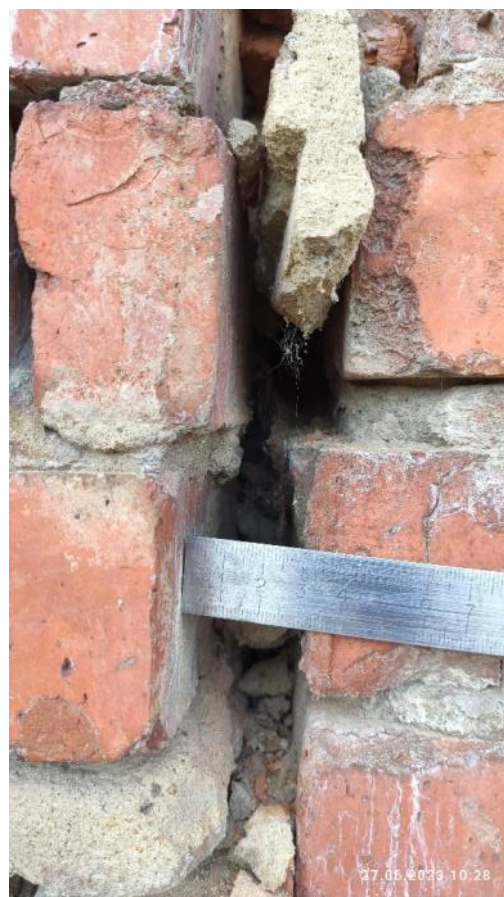
Рис. 33-34. Иллюстрация измерения ширины и глубины развития трещины
