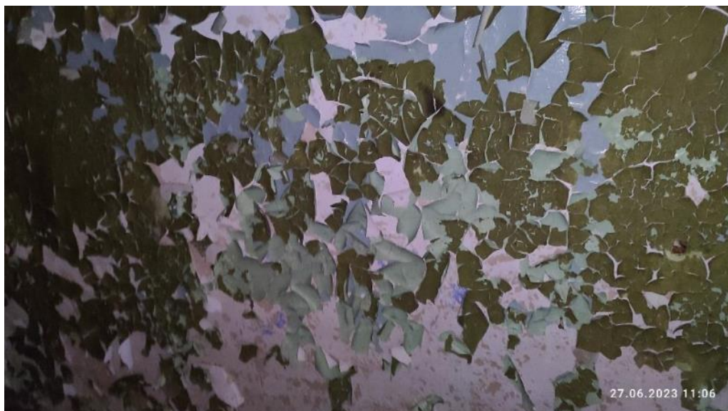
Рис. 152. Трещины, отслоения и вздутия отделочного слоя
