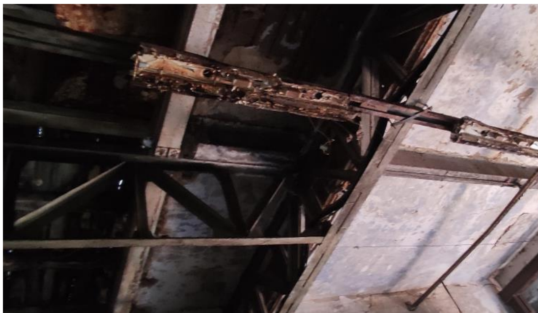
Рис. 77. Коррозия металлических ферм и балок покрытия
