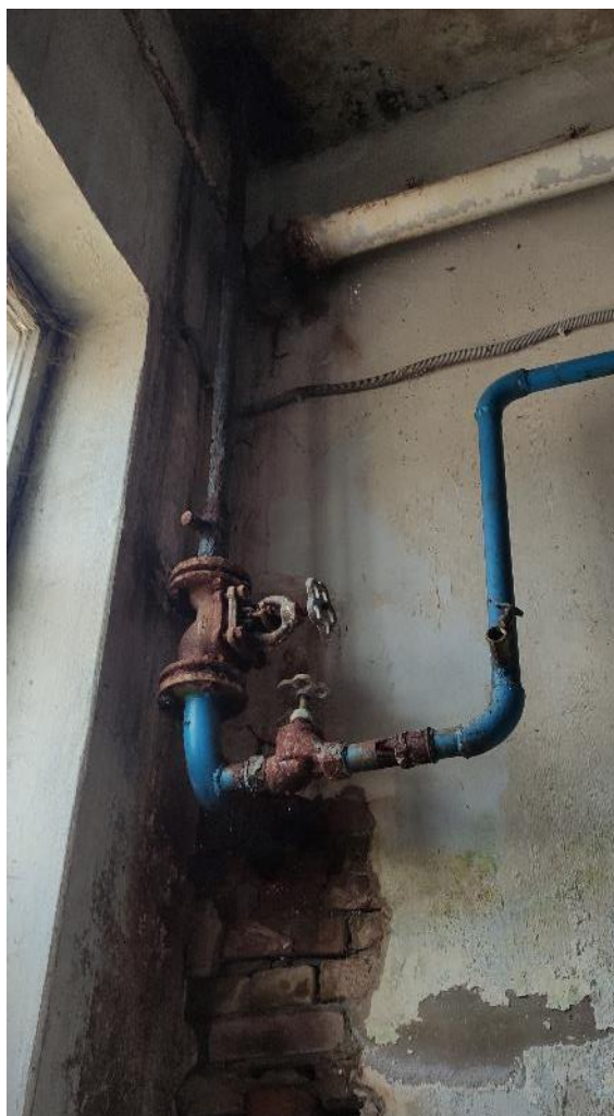
Рис. 174. Поражение коррозией трубопроводов отопления
