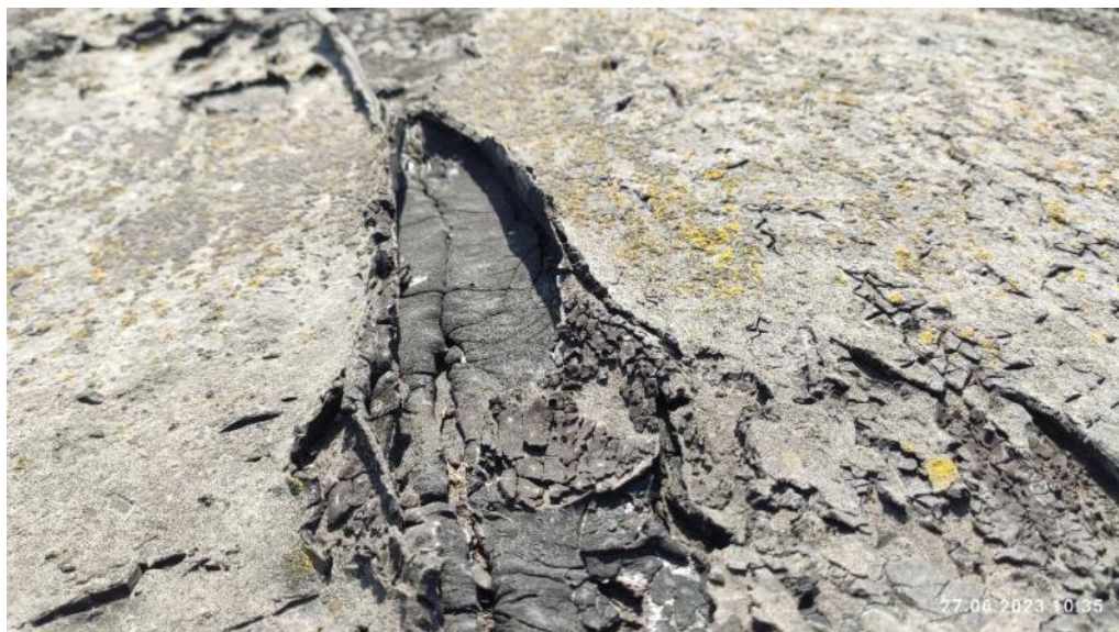
Рис. 106. Трещины и разрывы на кровельном покрытии
