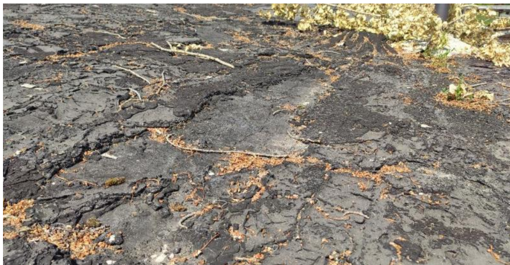
Рис. 97. Неплотное прилегание рулонной кровли к нижележащим слоям, вздутие и отслоение кровельного материала
