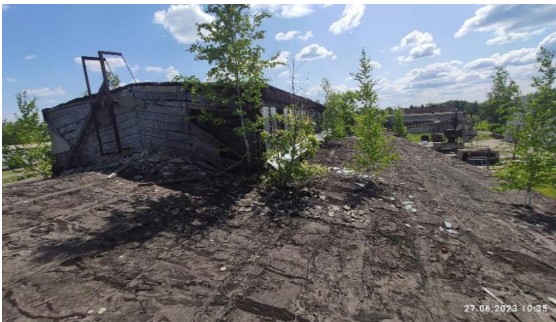
Рис. 93. Общий вид кровли. Значительный износ покрытия кровли, сплошные участки течи
