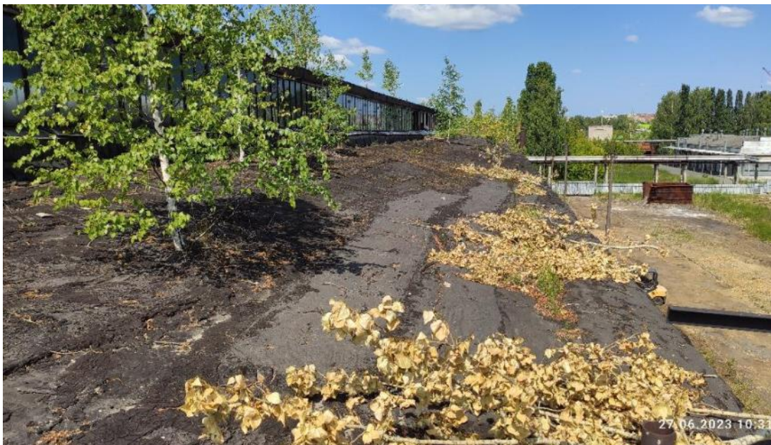
Рис. 92. Общий вид кровли. Повреждение целостности кровли, вздутия и разрывы, рост растительности на кровле
