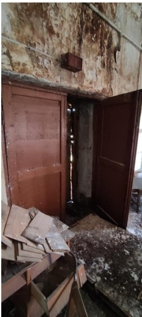
Рис. 141-142. Биоповреждение конструкций входных дверей, осадка полотен, двери имеют неплотный притвор по периметру коробки
