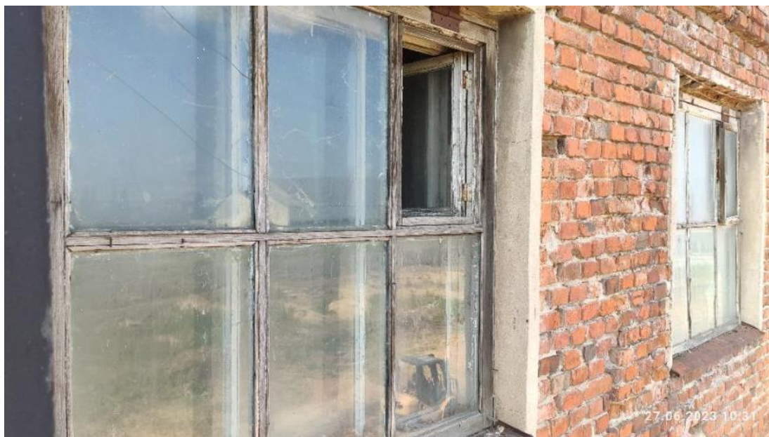
Рис. 133. Створки открываются с трудом и не закрываются, износ элементов
