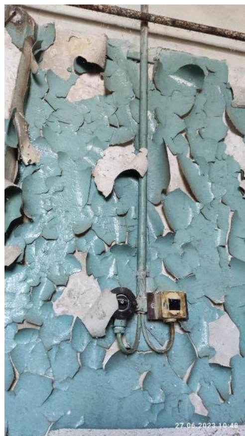
Рис. 163-164. Износ электроустановочных изделий
