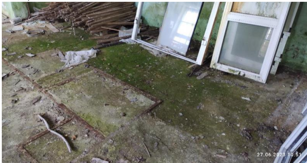
Рис. 108. Мелкие выбоины и трещины на покрытии полов, рост органики на поверхности
