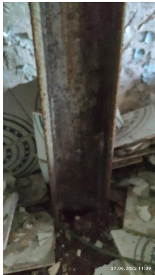
Рис. 47-48. Коррозия в местах сопряжений колонн с фундаментной частью
