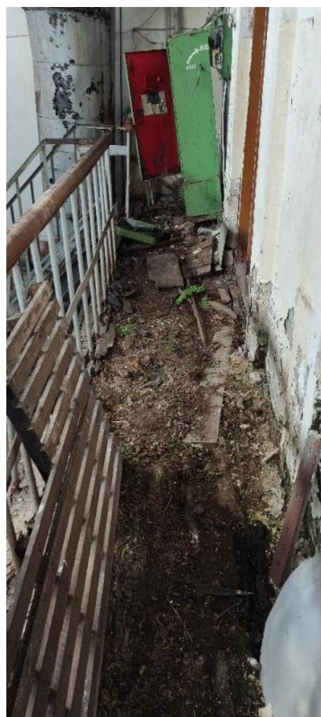
Рис. 112-113. Значительное биоповреждение деревянных конструкций полов, зыбкость конструкций
