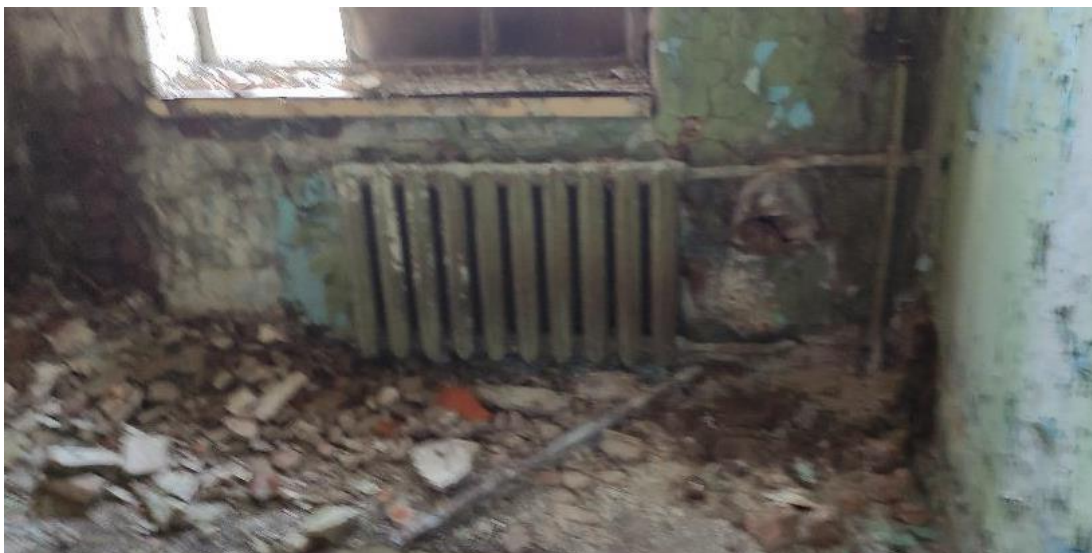
Рис. 176. Износ радиаторов системы отопления
