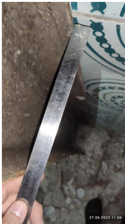
Рис. 55. Измерения высоты полки швеллера колонны (№ 18)
