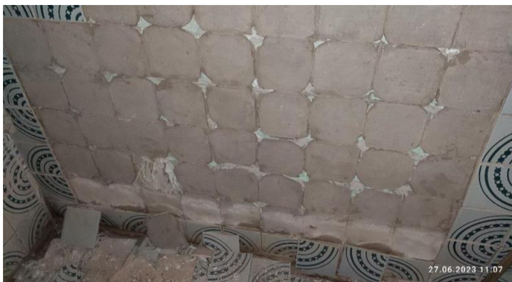
Рис. 154. Отслоение керамической плитки в санузлах
