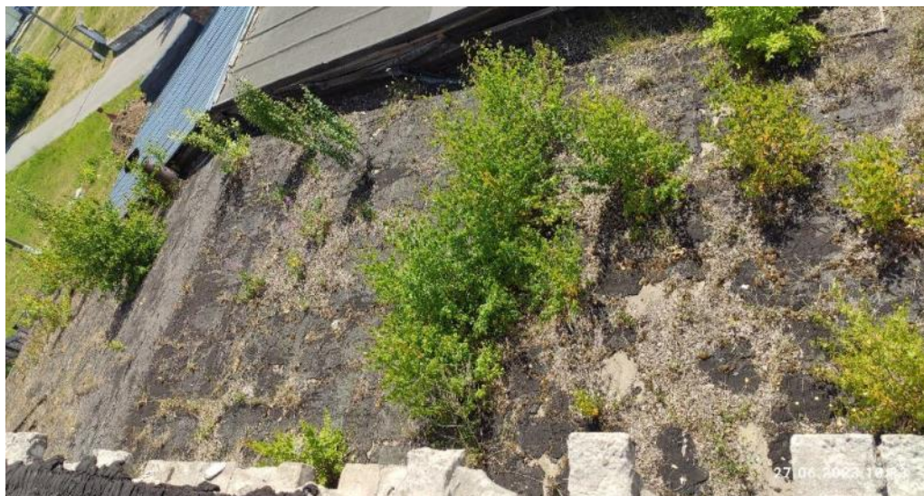
Рис. 100. Повреждение целостности кровельного покрытия, рост органики на поверхности кровли
