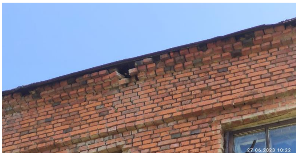
Рис. 30. Выпадение отдельных кирпичей в подкарнизной зоне (юго-западный фасад)
