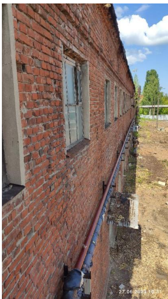
Рис. 36-37. Отклонение от вертикали и выпучивание стен
