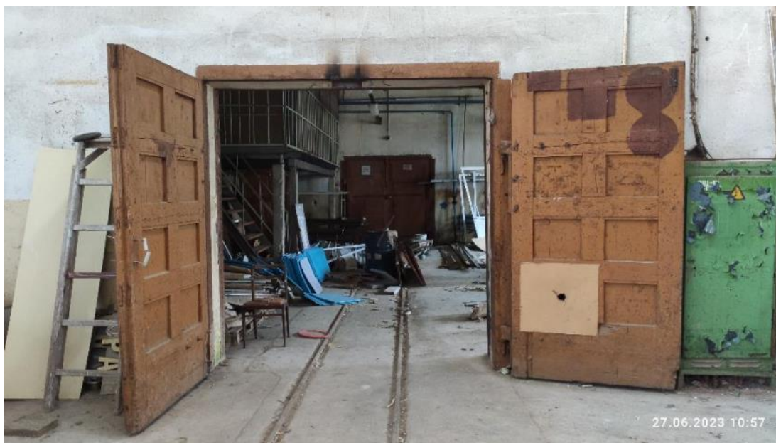
Рис. 143. Осадка дверных полотен, биоповреждение полотен и коробки
