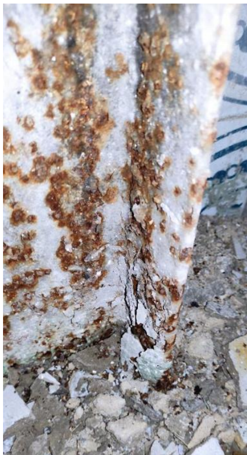
Рис. 41-42. Значительное поражение коррозией металлических колонн
