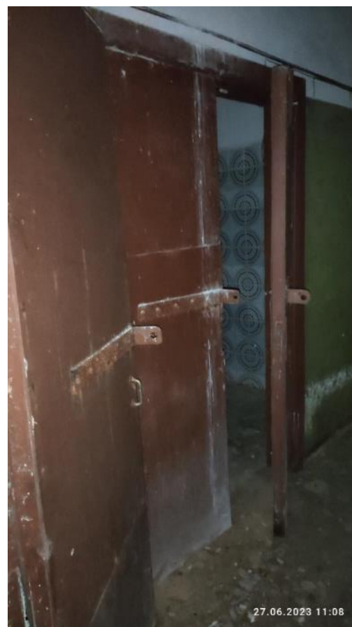
Рис. 144-145. Износ конструкций дверных блоков
