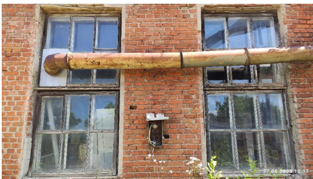
Рис. 123. Износ элементов оконных заполнений, перекос оконных косяков, часть
