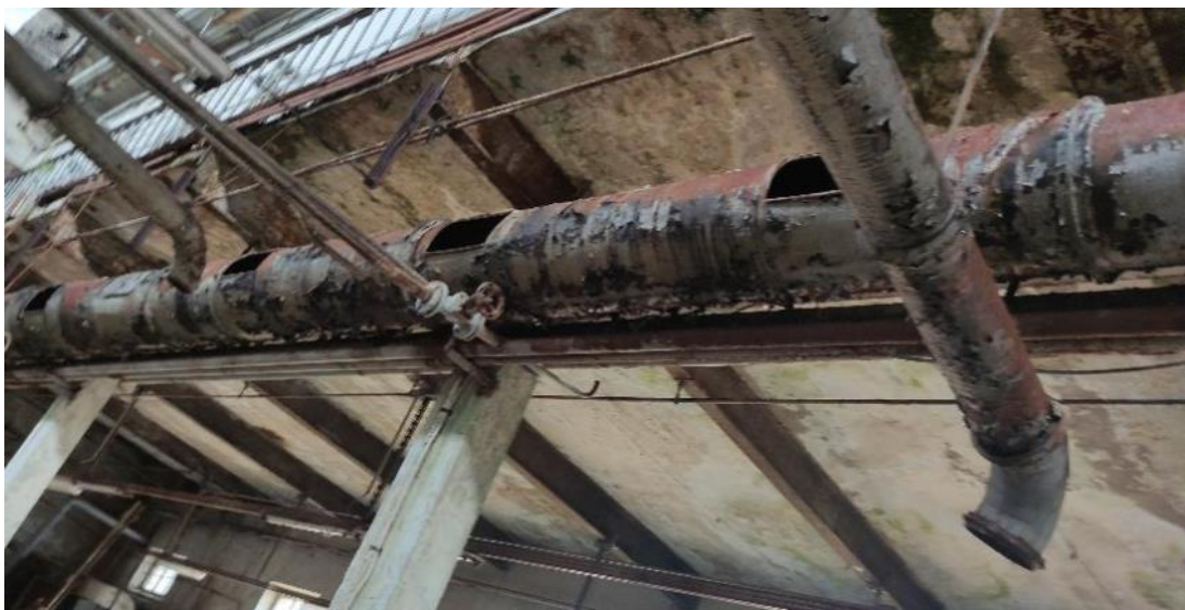
Рис. 179. Фактическая неработоспособность системы вентиляции
