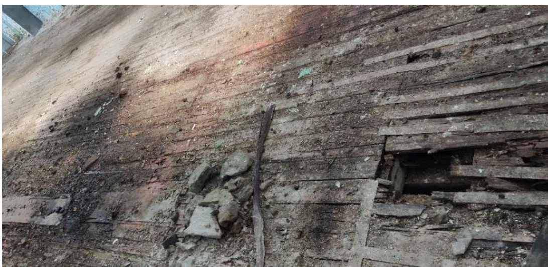
Рис. 115. Значительное поражение гнилью деревянных полов, зыбкость конструкций, щели между досками
