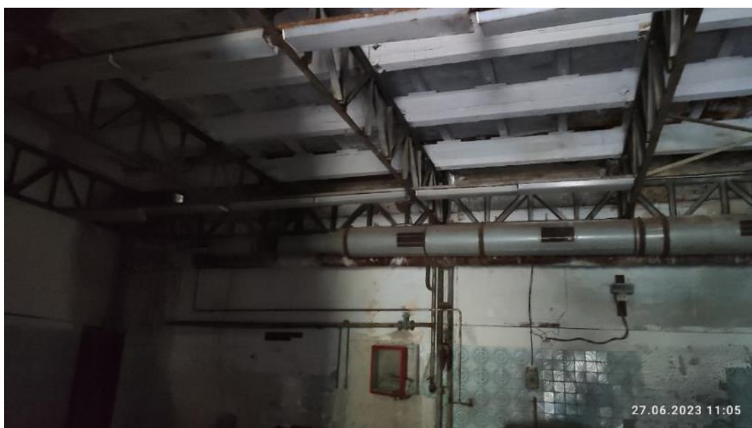
Рис. 67. Вид на металлические фермы и плиты ПКЖ
