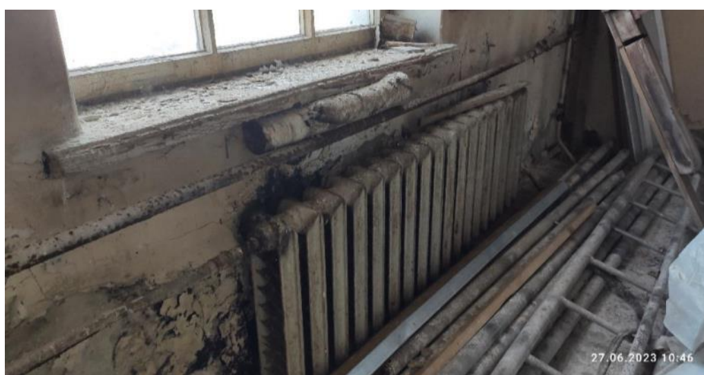
Рис. 169. Фактическая неработоспособность системы отопления
