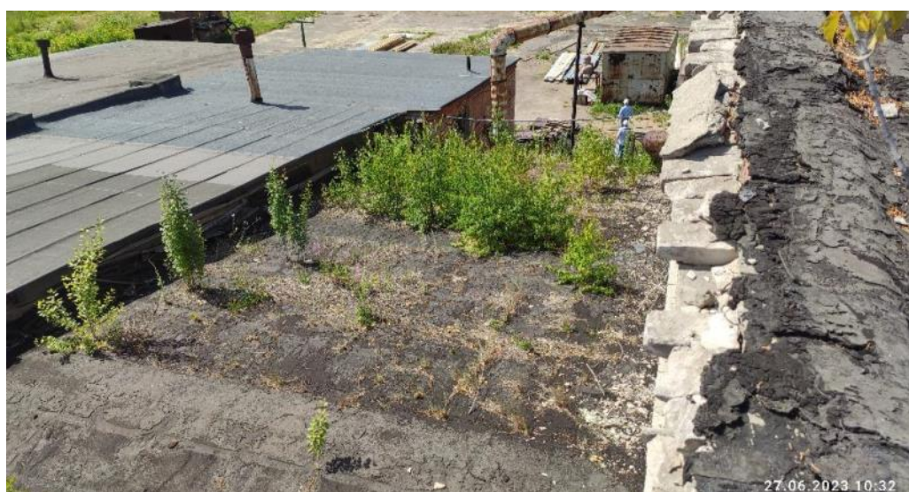
Рис. 96. Рост растительности (деревьев) на поверхности кровельного покрытия
