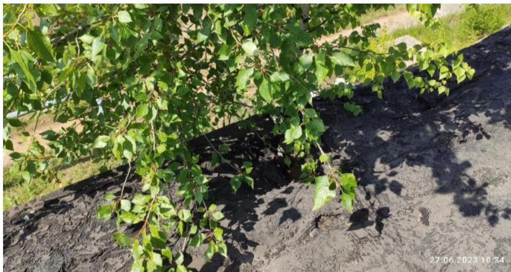
Рис. 103. Рост растительности на кровельном покрытии
