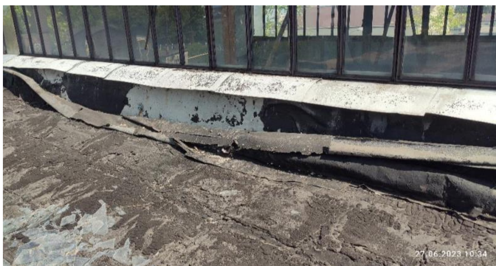
Рис. 101. Трещины и разрывы кровельного материала в зоне примыкания со световым фонарем
