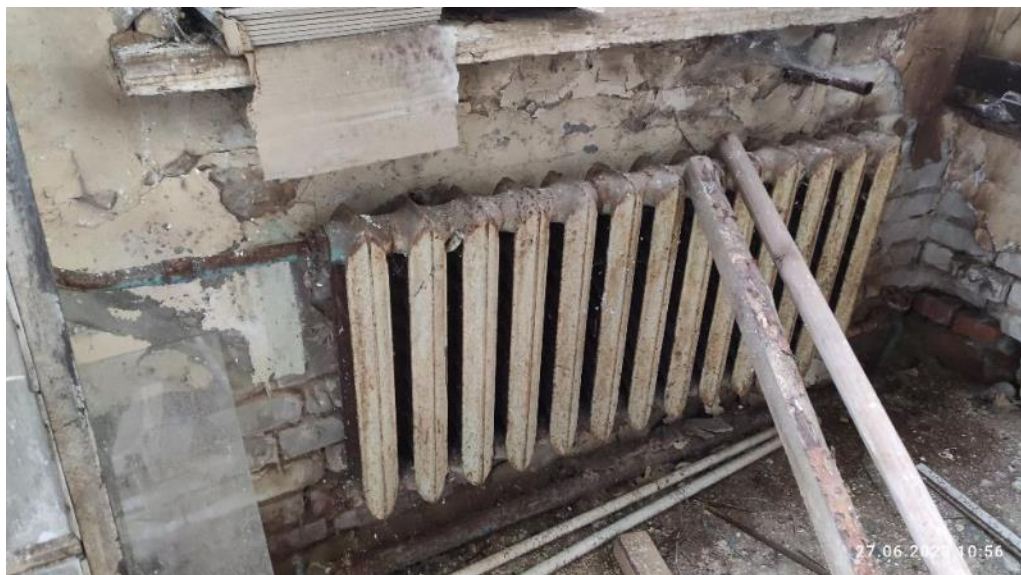
Рис. 170. Коррозия радиаторов отопления
