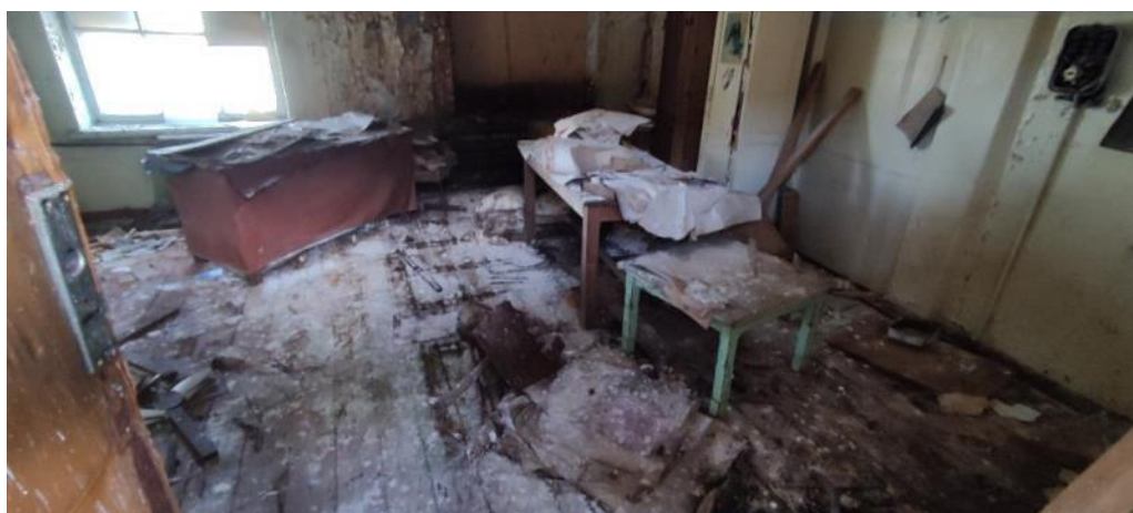
Рис. 110. Значительный износ покрытия полов
