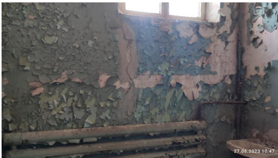
Рис. 146. Растрескивание отделочного слоя, потемнение и загрязнение
