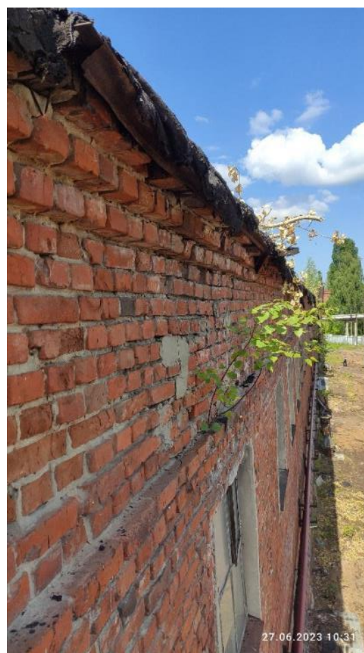
Рис. 36-37. Отклонение от вертикали и выпучивание стен
