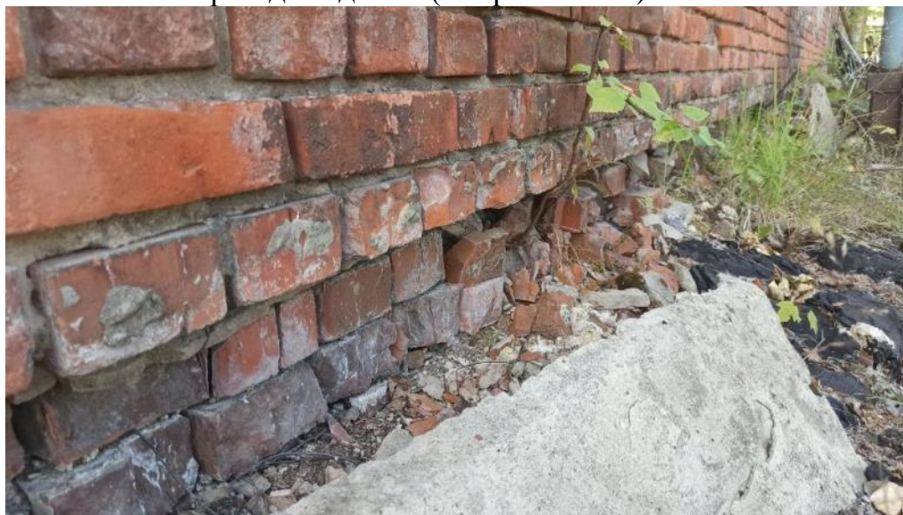
Рис. 20. Выкрашивание кирпича цоколя, трещины в кладке
