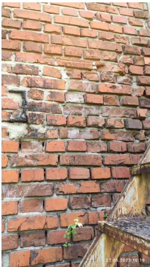
Рис. 31. Замачивание кладки
