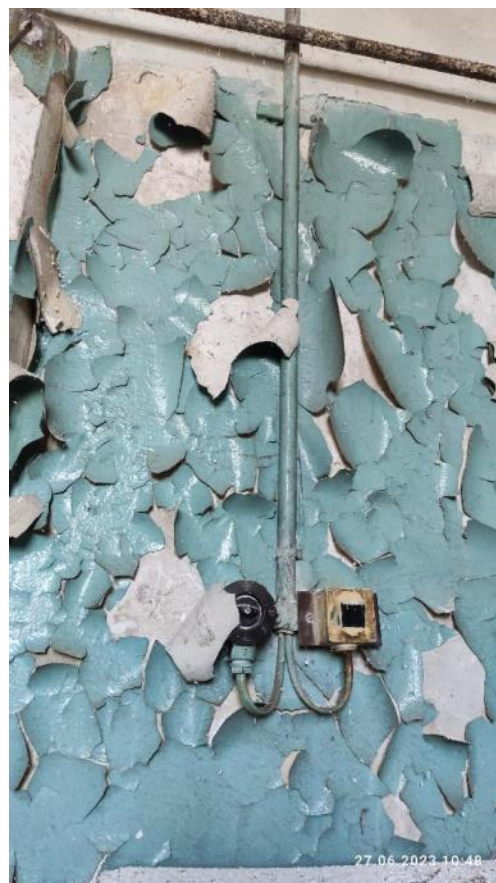
Рис. 148-149. Износ отделочного покрытия стен
