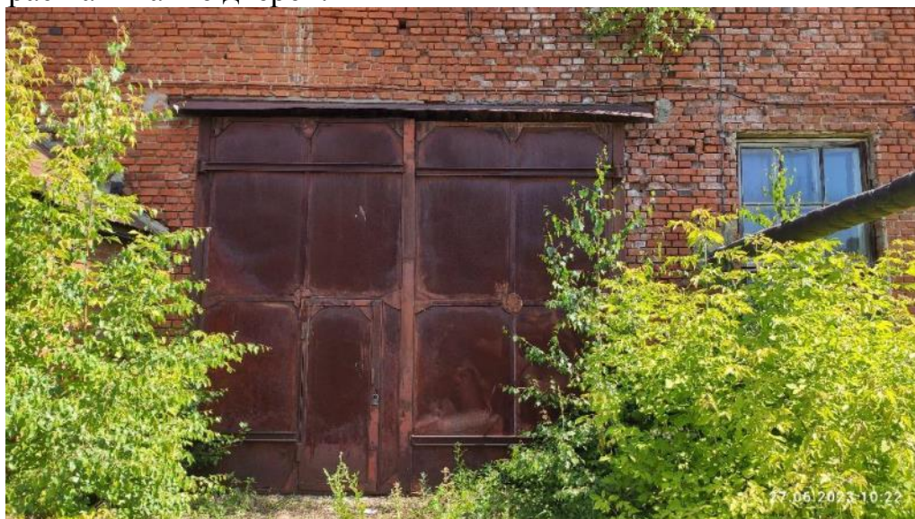
Рис. 136. Коррозия дверных полотен, петель, закладных деталей
