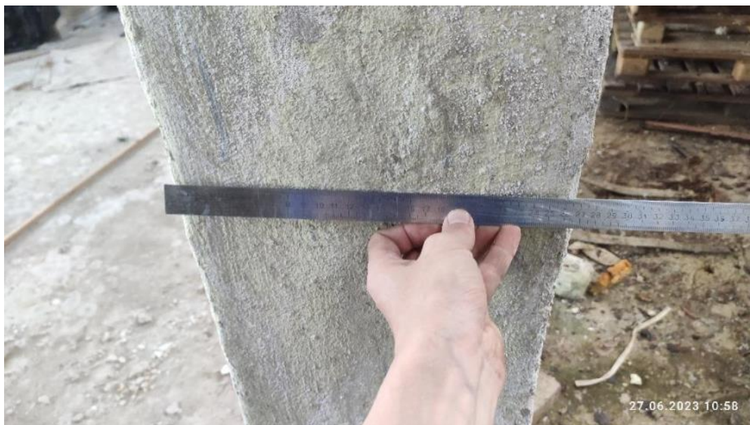
Рис. 56. Измерение длины сечения металлической колонны (взятой в бетонную обойму для защиты от коррозии)
