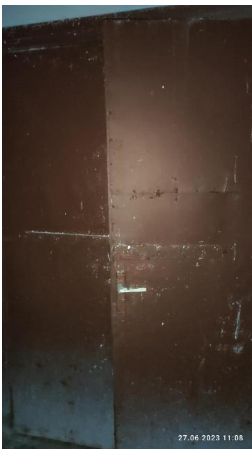
Рис. 144-145. Износ конструкций дверных блоков
