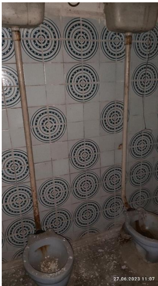
Рис. 182. Износ внутренних санитарно-технических устройств в помещении уборной
