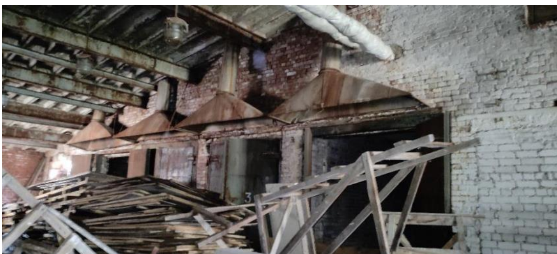
Рис. 180. Износ системы вентиляции
