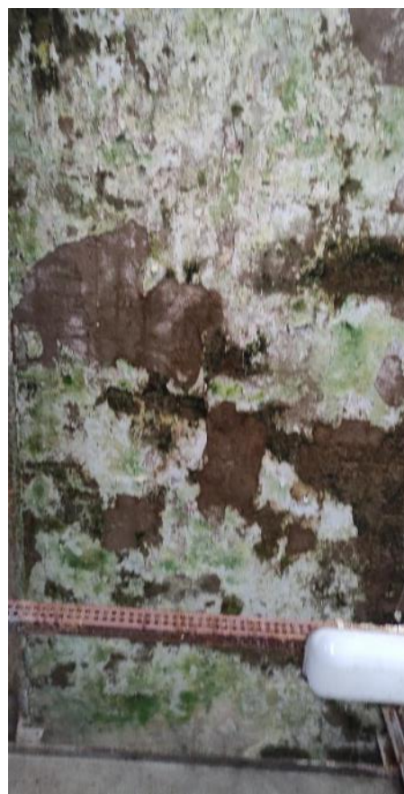
Рис. 150-151. Биоповреждение и замачивание отделки
