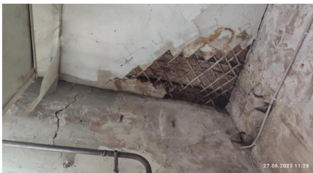
Рис. 85. Выпадение штукатурки, оголение и биоповреждение деревянных элементов перекрытия
