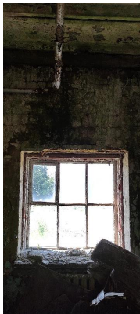
Рис. 134-135. Биоповреждение деревянных элементов оконных блоков. Отсутствие остекления местами
