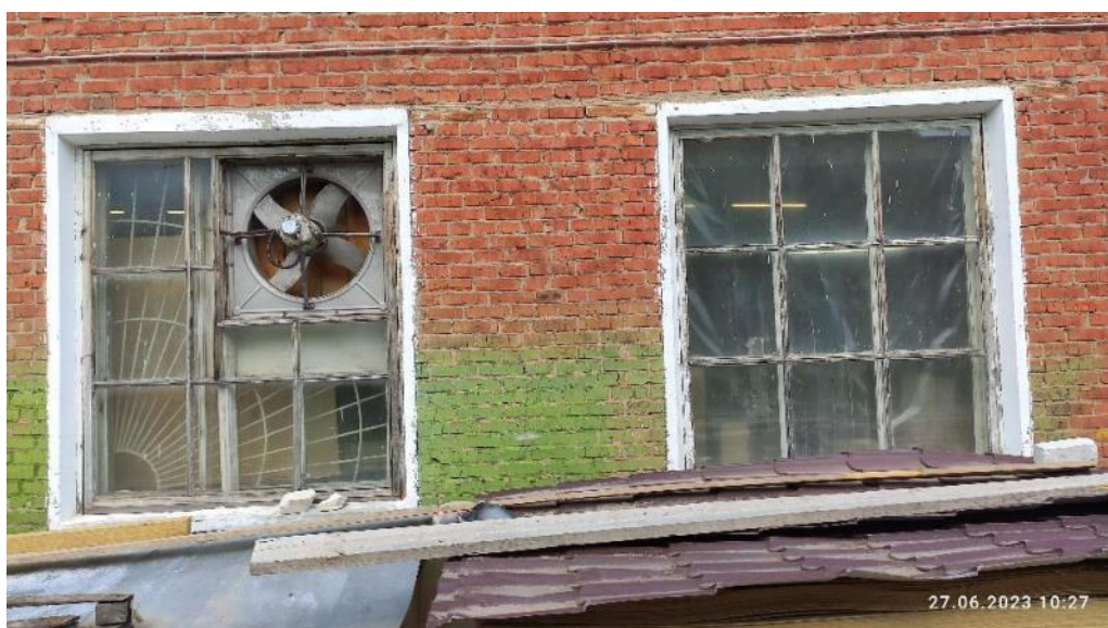
Рис. 132. Износ элементов заполнения оконного проема
