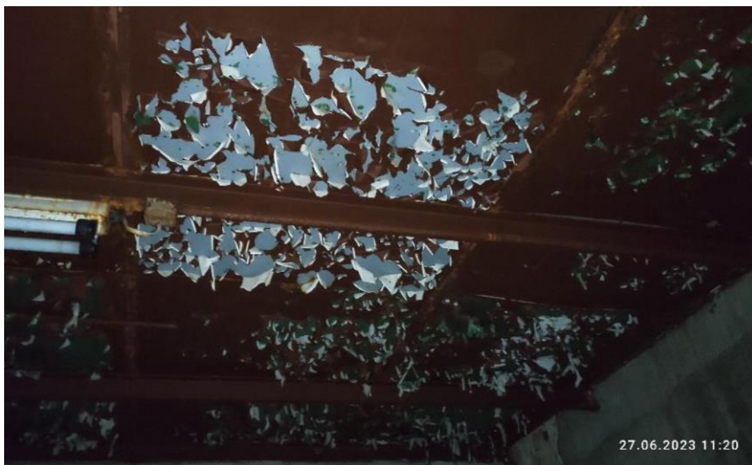
Рис. 81. Значительное поражение коррозией металлических балок покрытия
