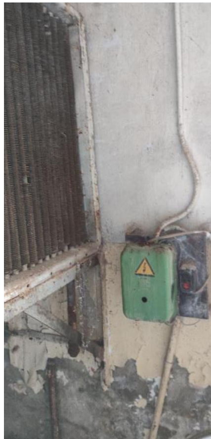
Рис. 159-160. Износ системы электрооснабжения
