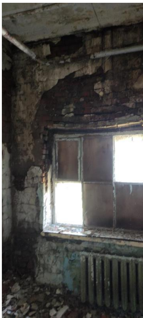
Рис. 134-135. Биоповреждение деревянных элементов оконных блоков. Отсутствие остекления местами
