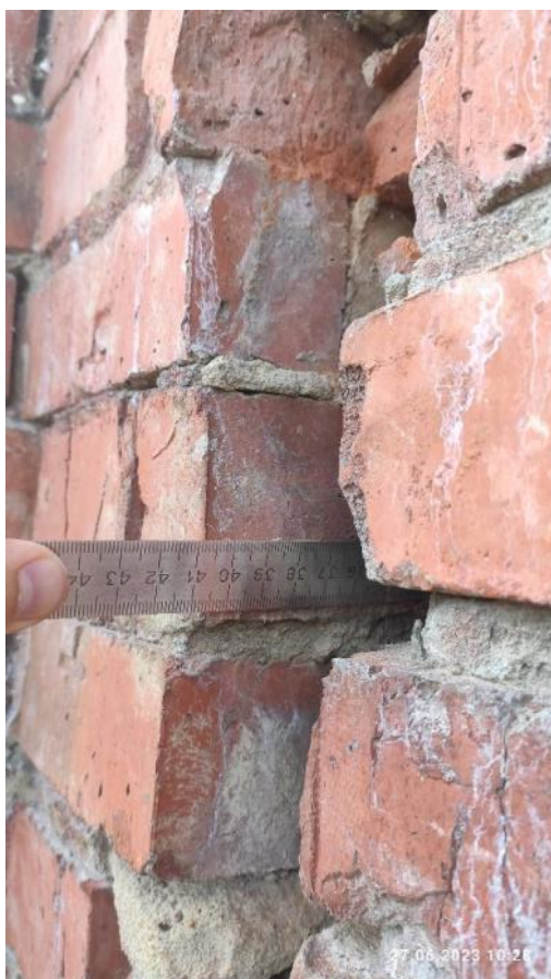
Рис. 33-34. Иллюстрация измерения ширины и глубины развития трещины
