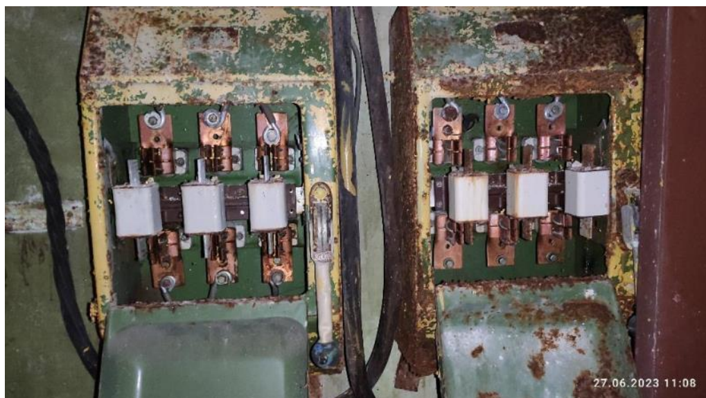
Рис. 167. Фактическая неработоспособность системы электроснабжения
