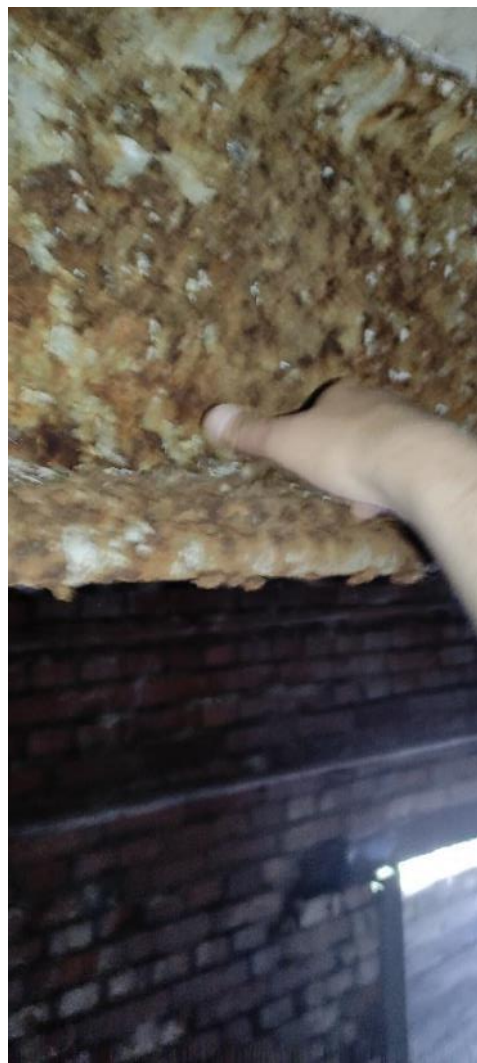
Рис. 75-76. Снижение толщины сечения балки покрытия в результате сплошного поражения коррозией. Опасно!
