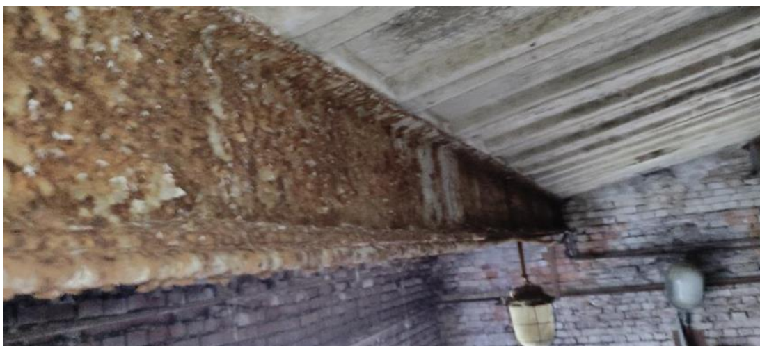
Рис. 74. Коррозия металлических балок, снижение несущей способности балки
