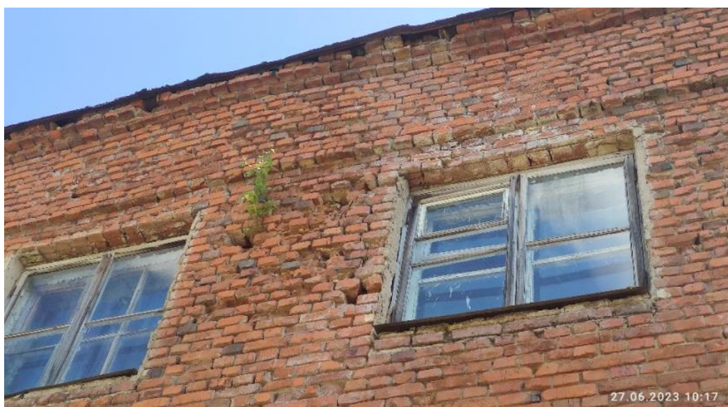
Рис. 126. Оконные переплеты, коробка поражены гнилью, створки открываются с трудом
