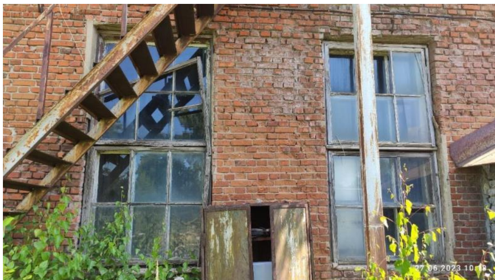
Рис. 130. Износ деревянных оконных блоков
