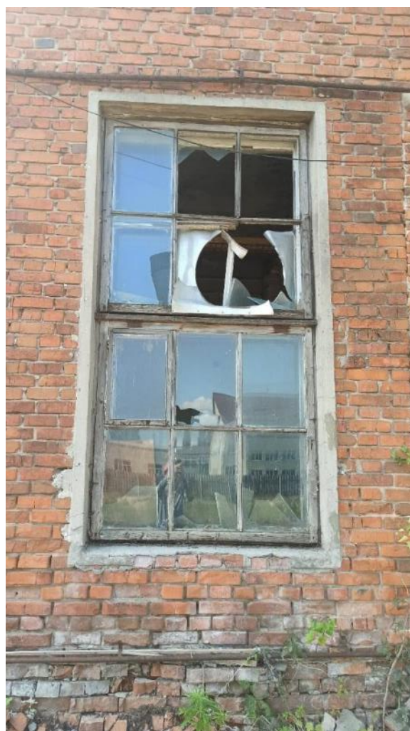
Рис. 128-129. Оконные рамы, коробка и подоконная доска полностью поражены гнилью
