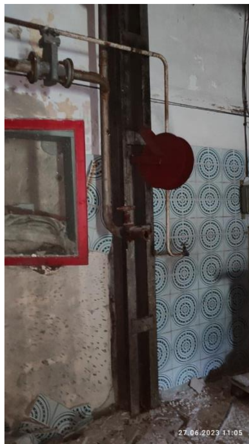
Рис. 45-46. Сплошное поражение коррозией металлических колонн каркаса
