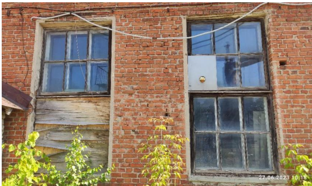
Рис. 127. Износ элементов заполнения оконного проема
