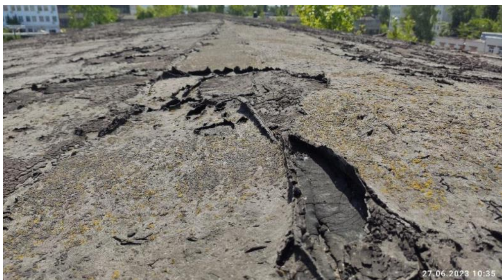
Рис. 105. Разрывы на кровельном основании на стыках с парапетом, протечки кровли
