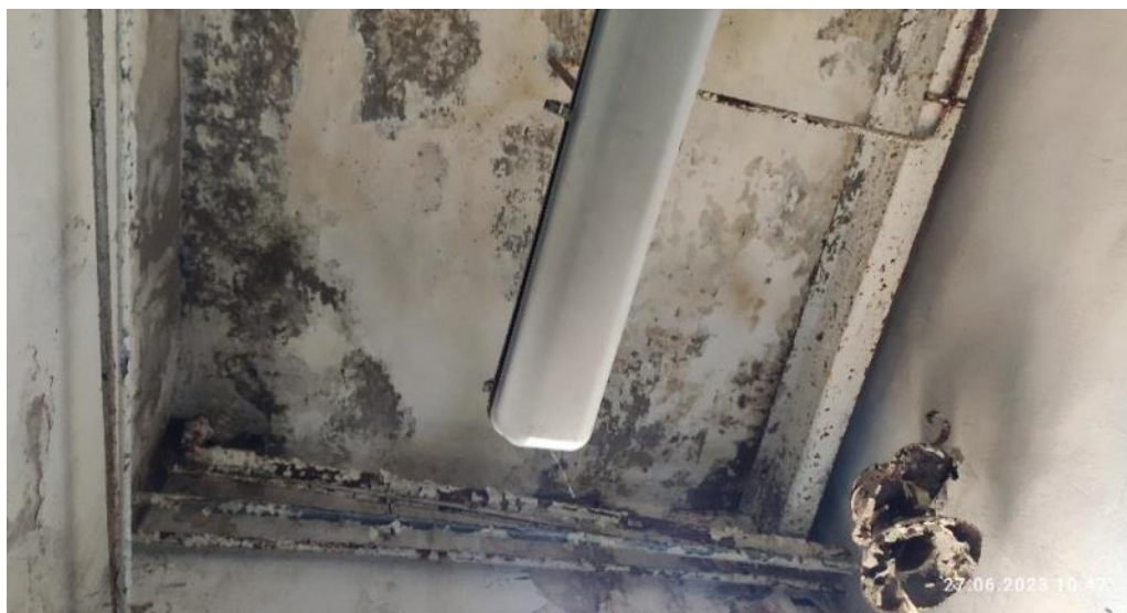
Рис. 153. Биоповреждение (поражение плесенью) отделочного слоя
