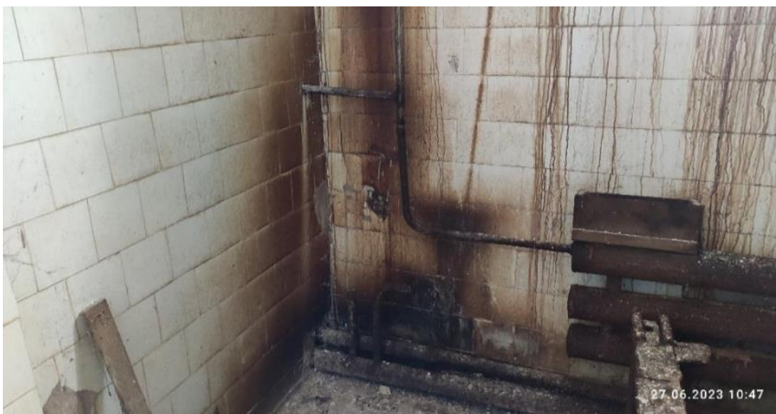
Рис. 178. Поражение коррозией трубопроводов инженерных систем
