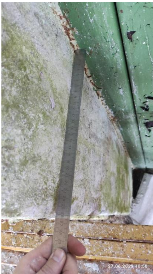
Рис. 54. Измерение ширины сечения колонны
