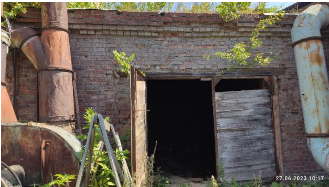
Рис. 140. Износ конструкций ворот, отсутствие материала полотна местами
