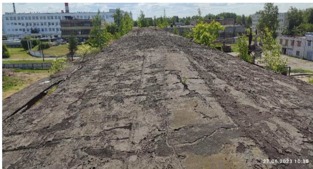
Рис. 94. Износ кровельного покрытия
