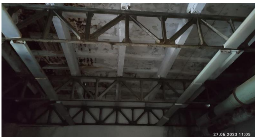
Рис. 80. Износ металлических ферм
