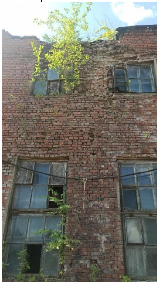
Рис. 26. Замачивание кладки стен (северо-восточный фасад)
