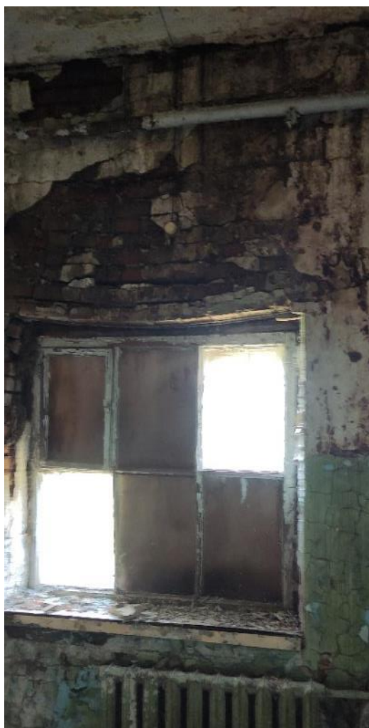
Рис. 39. Сквозные трещины в кладке стен, промерзание стен
