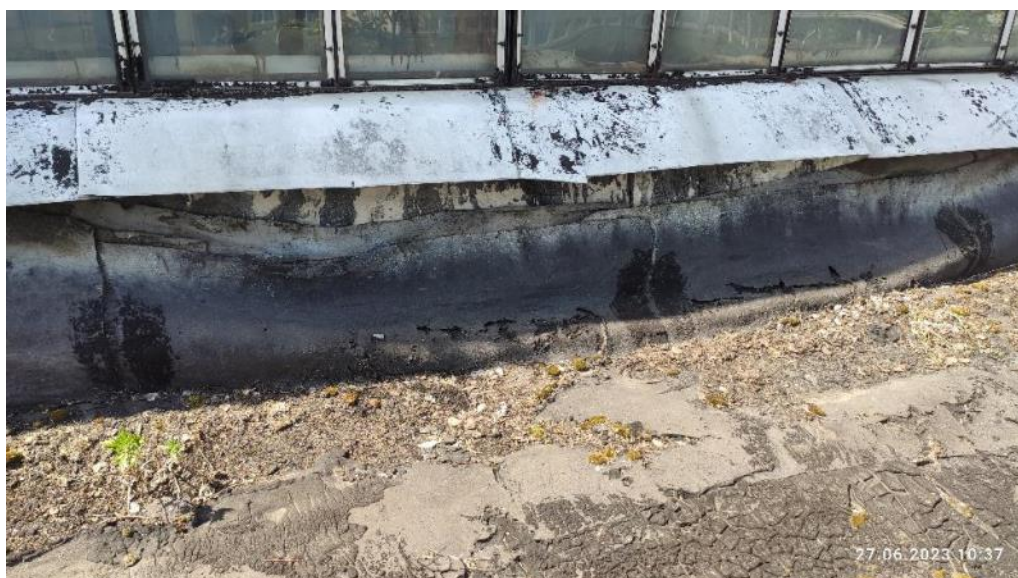
Рис. 107. Неплотное прилегание рулонного гидроизоляционного ковра к конструкции светового фонаря
