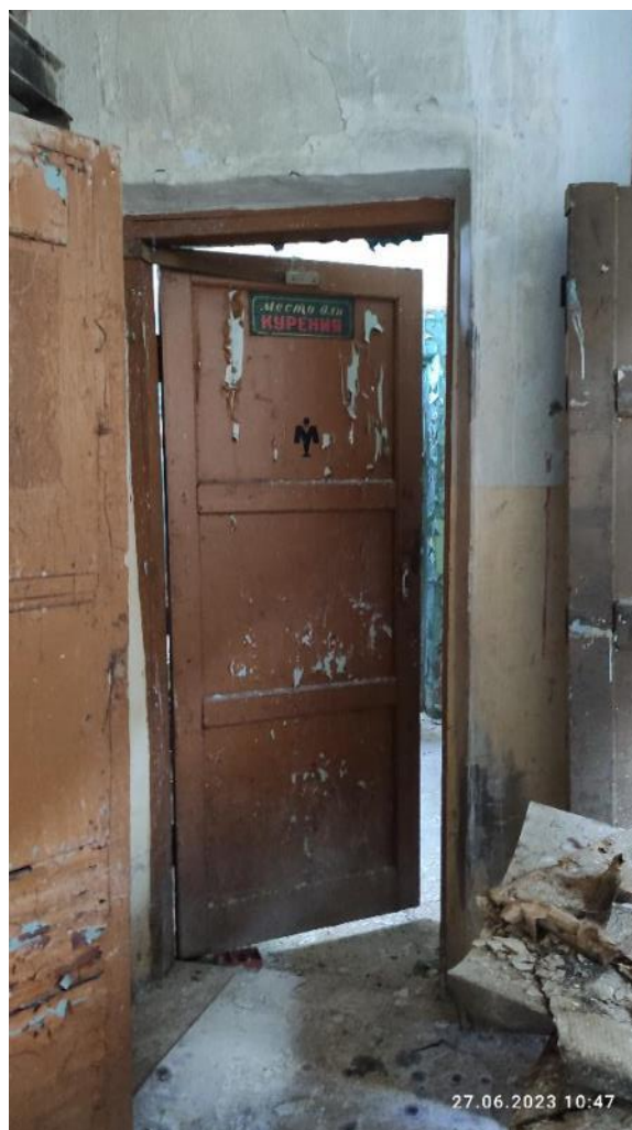
Рис. 141-142. Биоповреждение конструкций входных дверей, осадка полотен, двери имеют неплотный притвор по периметру коробки
