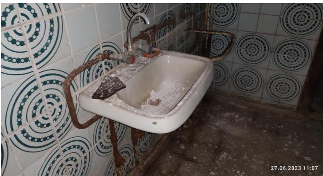
Рис. 181. Износ внутренних санитарно-технических устройств
