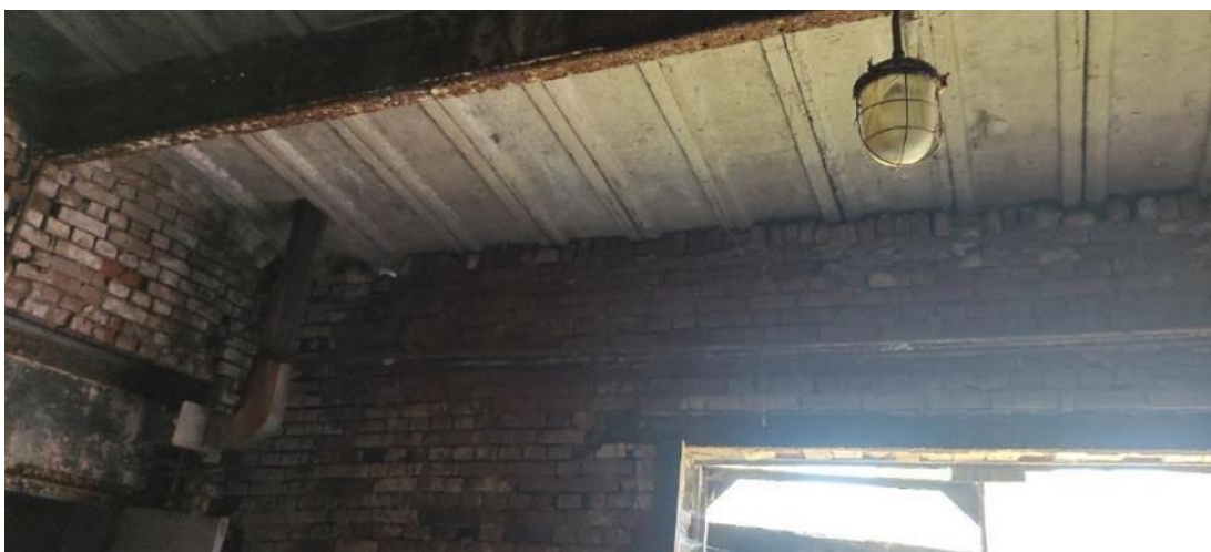
Рис. 73. Прогибы балок, поражение коррозией
