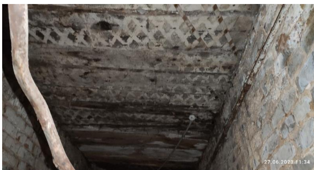
Рис. 84. Поражение конструкций гнилью, оголение дранки
