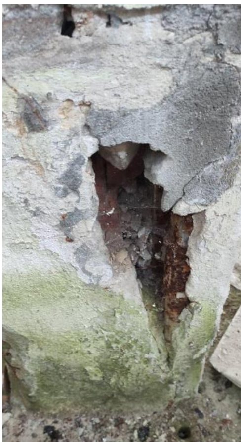
Рис. 43-44. Повреждение слоя бетона колонны
