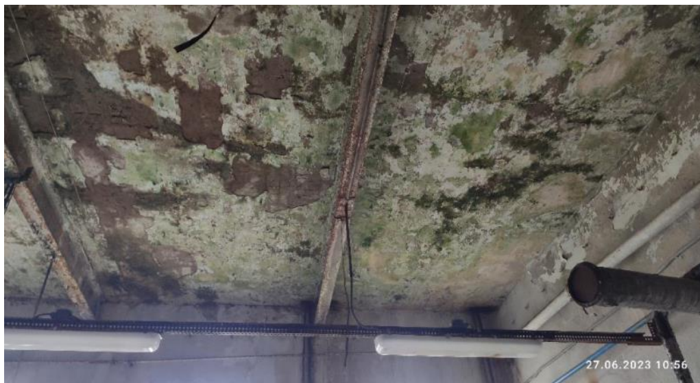
Рис. 78. Следы течи кровли, биоповреждение конструкций покрытия, оголение арматуры
