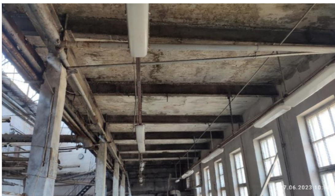
Рис. 65. Общий вид на балки и монолитные плиты перекрытия 2-ого этажа
