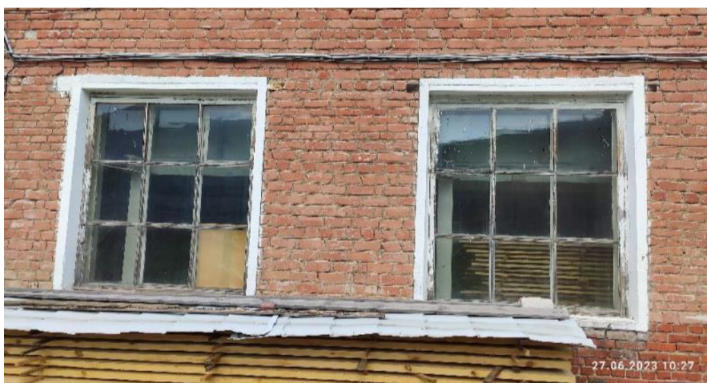
Рис. 131. Биоповреждение оконных створок и коробки, трещины на стеклах
