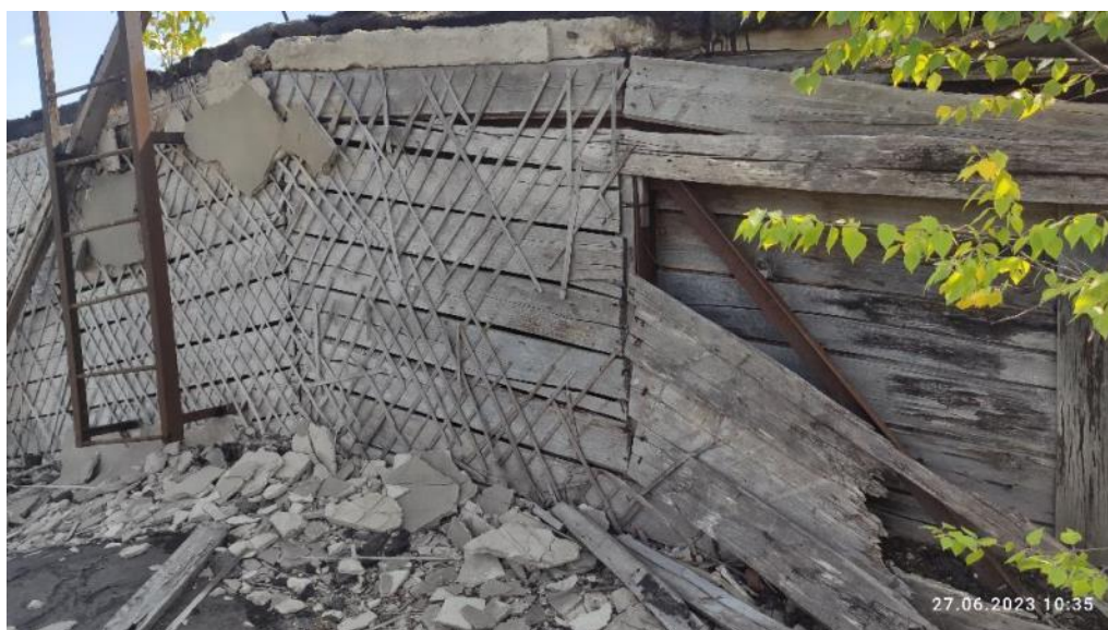
Рис. 104. Разрушение боковой части ограждения светового фонаря
