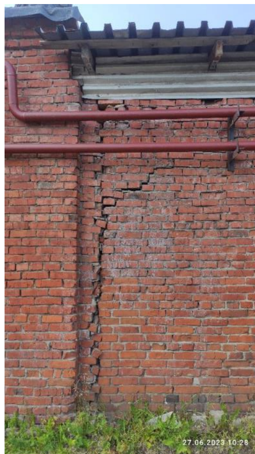
Рис. 32. Сквозные трещины в кладке
