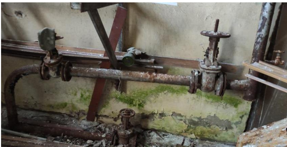
Рис. 177. Износ элементов системы отопления
