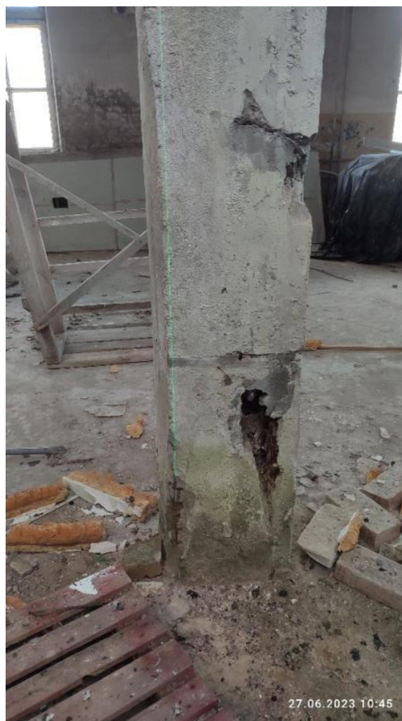
Рис. 40. Повреждение защитного слоя бетона, отклонения от вертикали
