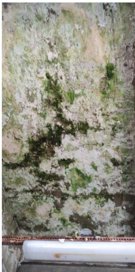
Рис. 150-151. Биоповреждение и замачивание отделки
