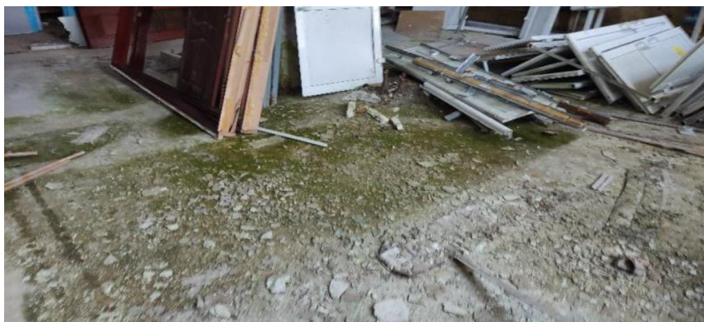
Рис. 109. Рост органики (мха) на поверхности бетонных полов
