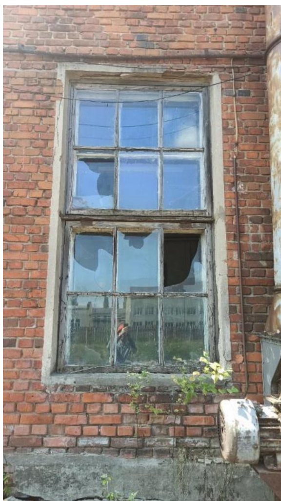
Рис. 128-129. Оконные рамы, коробка и подоконная доска полностью поражены гнилью
