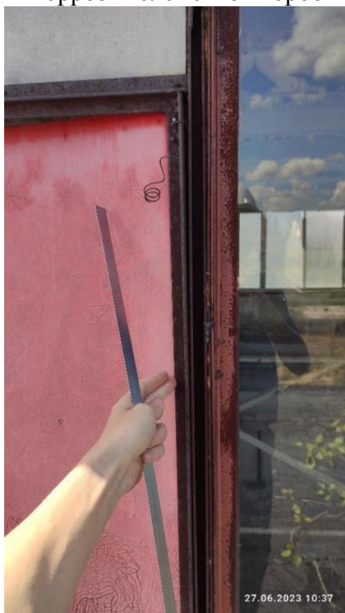
Рис. 120-121. Износ уплотнительных прокладок, трещины на стеклах, коррозия профилей
