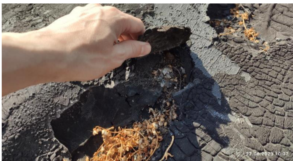
Рис. 98. Трещины и разрывы на поверхности кровли
