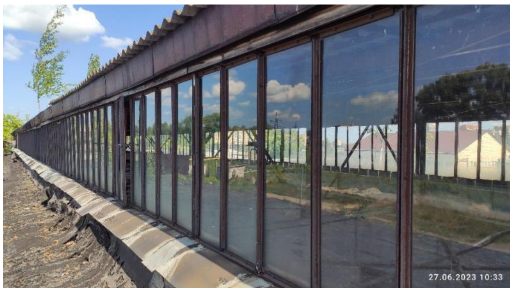
Рис. 122. Коррозия элементов коробки, трещины на стеклах, износ уплотнительных прокладок, отсутствие остекления местами
