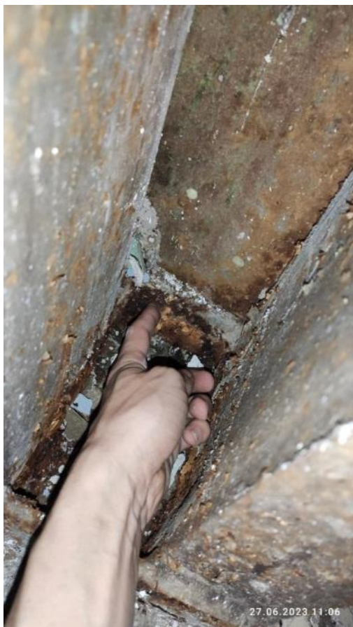
Рис. 47-48. Коррозия в местах сопряжений колонн с фундаментной частью
