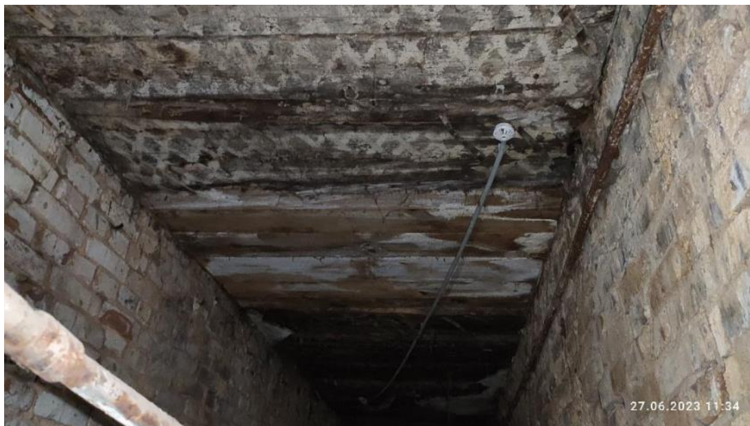
Рис. 86. Поражение гнилью деревянных перекрытий в помещении сушильной. Опасность обрушения!
