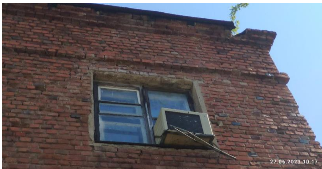
Рис. 124. Износ элементов заполнения оконного проема
