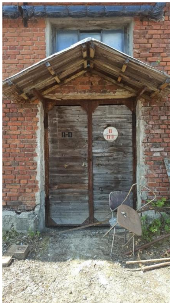
Рис. 137-138. Износ конструкций входных дверей, осадка полотен
