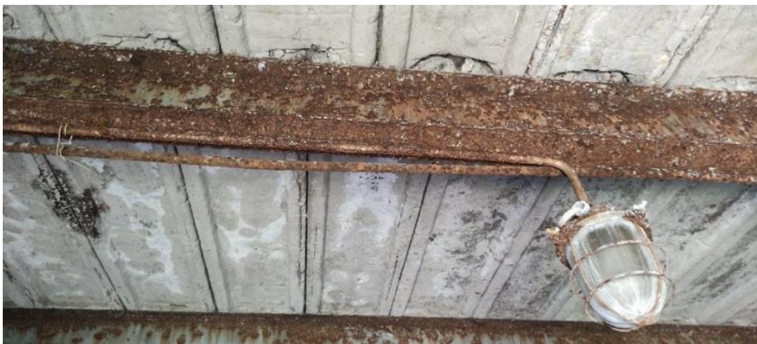
Рис. 72. Значительное поражение коррозией металлических балок
