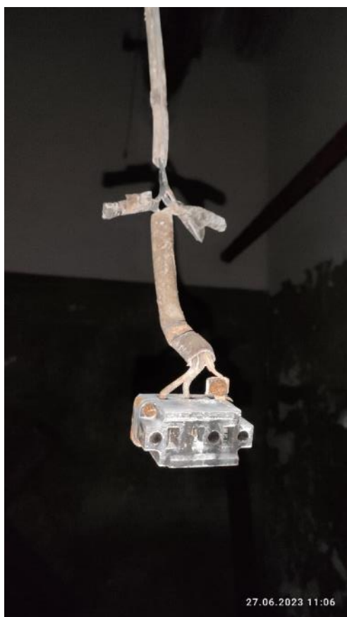
Рис. 165-166. Износ системы электроснабжения
