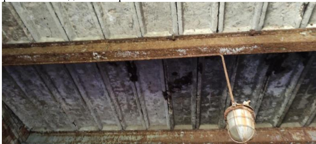
Рис. 69. Замачивание плит ПКЖ, оголение и коррозия арматуры на ребрах плит
