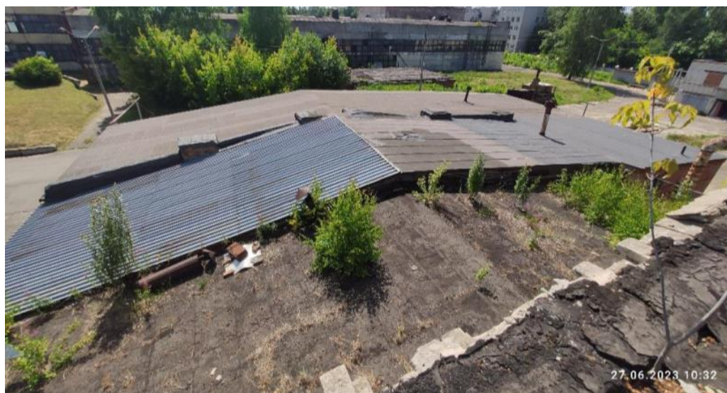
Рис. 95. Повреждение целостности кровли, трещины и разрывы, неплотности прилегания кровли к нижележащим слоям. Рост растительности на поверхности
