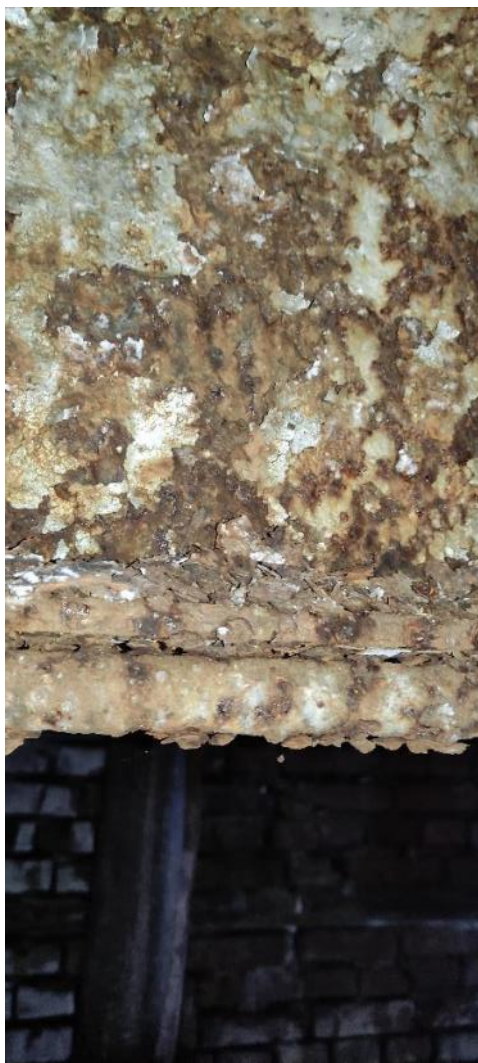
Рис. 75-76. Снижение толщины сечения балки покрытия в результате сплошного поражения коррозией. Опасно!
