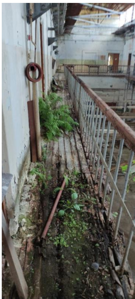
Рис. 112-113. Значительное биоповреждение деревянных конструкций полов, зыбкость конструкций
