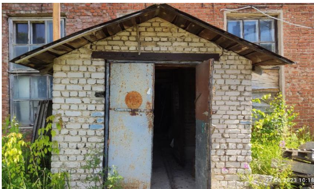
Рис. 139. Коррозия дверных полотен и коробки
