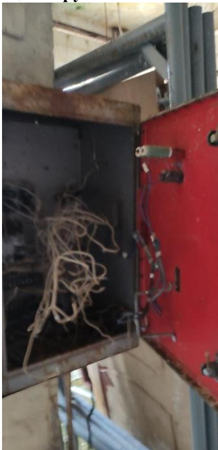
Рис. 156. Износ электрических щитков, коррозия коробок
