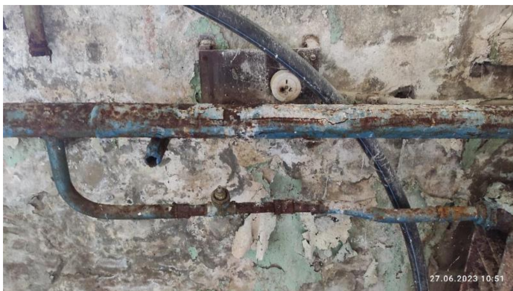
Рис. 172. Фактическая неработоспособность системы отопления
