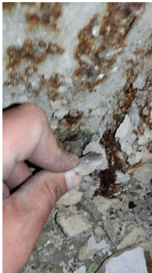
Рис. 41-42. Значительное поражение коррозией металлических колонн
