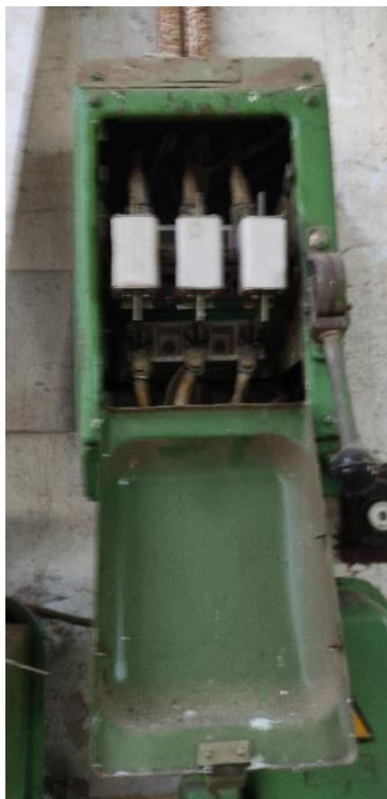
Рис. 159-160. Износ системы электрооснабжения
