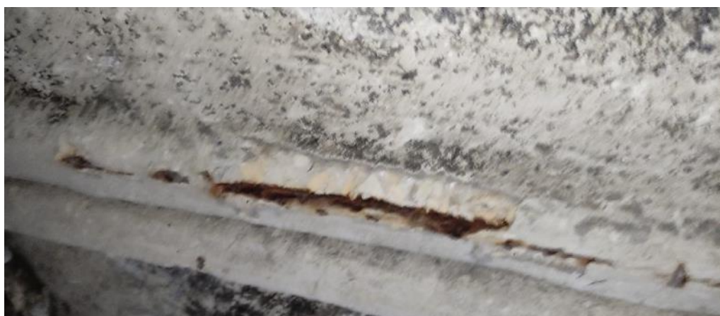
Рис. 70. Оголение и коррозия арматуры на ребрах плит ПКЖ
