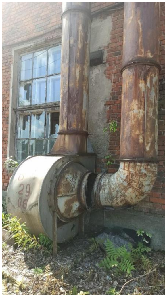
Рис. 175. Износ системы вентиляции
