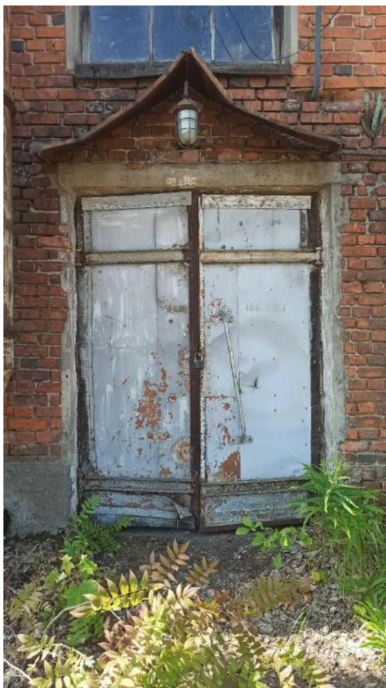
Рис. 137-138. Износ конструкций входных дверей, осадка полотен
