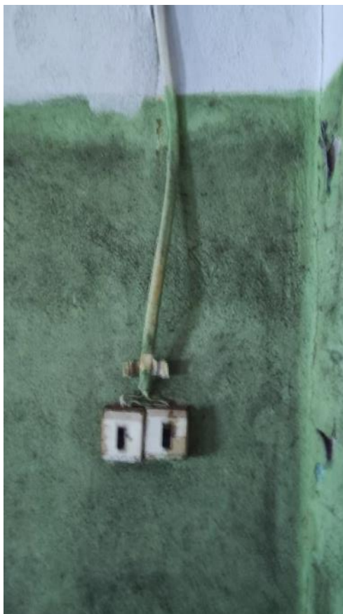
Рис. 163-164. Износ электроустановочных изделий
