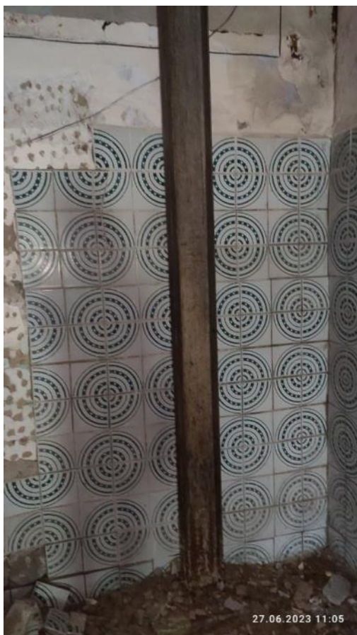
Рис. 45-46. Сплошное поражение коррозией металлических колонн каркаса
