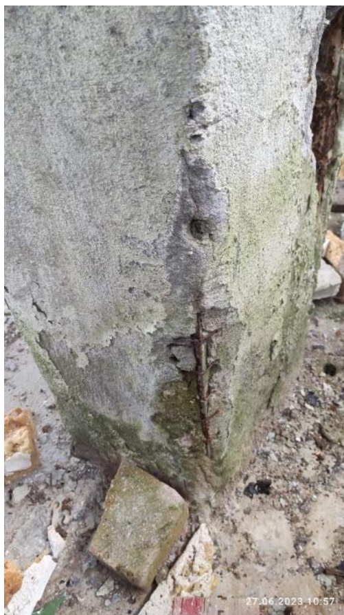
Рис. 43-44. Повреждение слоя бетона колонны
