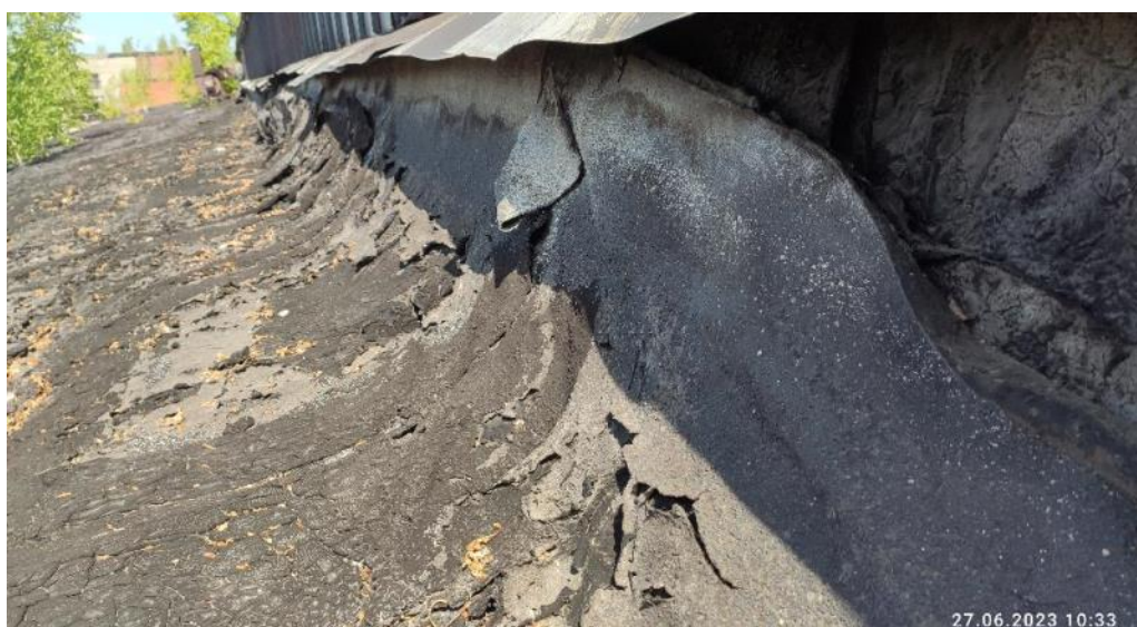
Рис. 102. Повреждение целостности кровли в зоне примыкания светового фонаря
