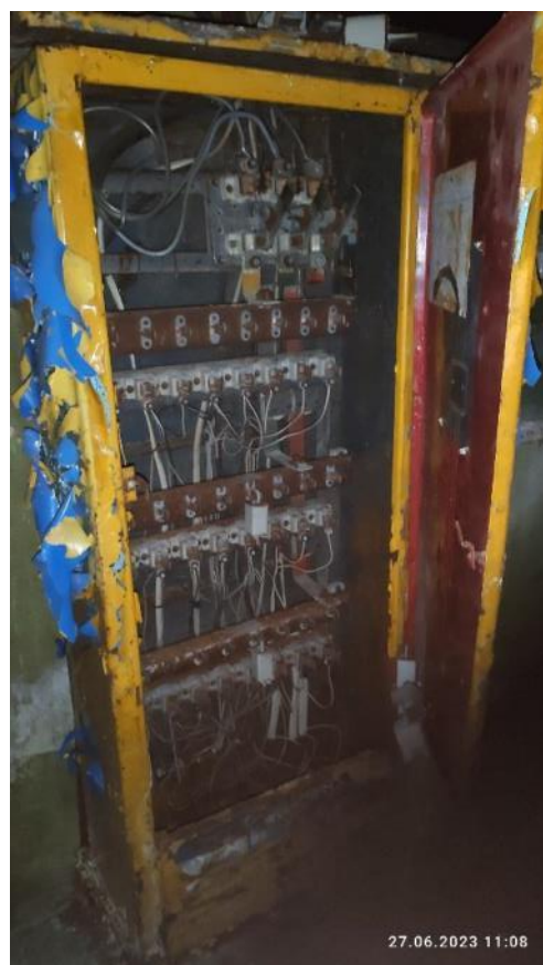
Рис. 165-166. Износ системы электроснабжения
