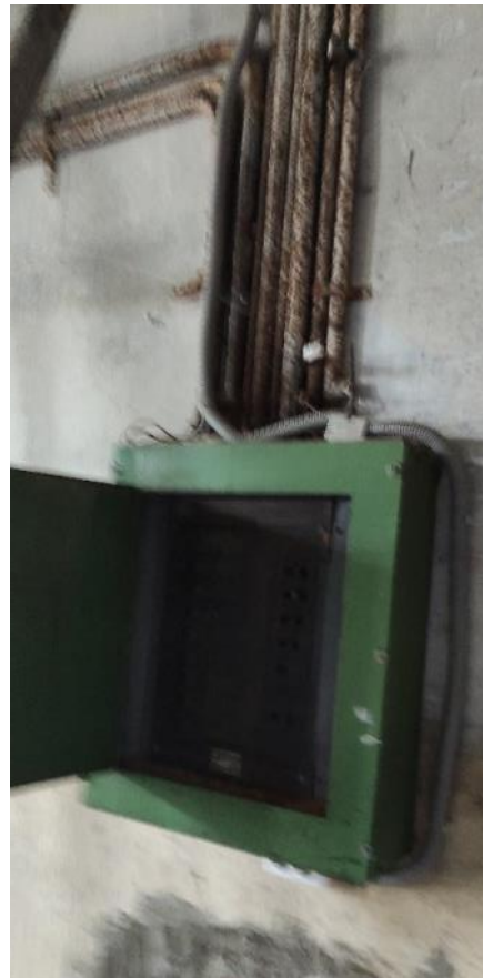
Рис. 157. Износ вводно-распределительных устройств электрической сети, следы коррозии
