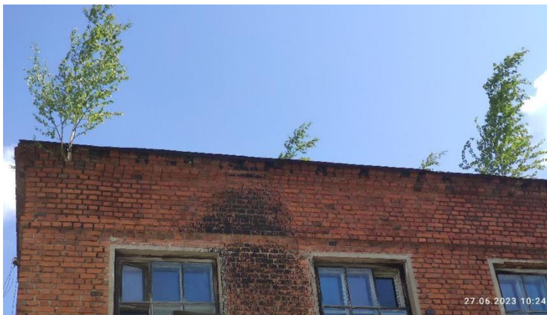
Рис. 35. Жизнедеятельность деревьев в толще конструкций стен (северо-восточный фасад)
