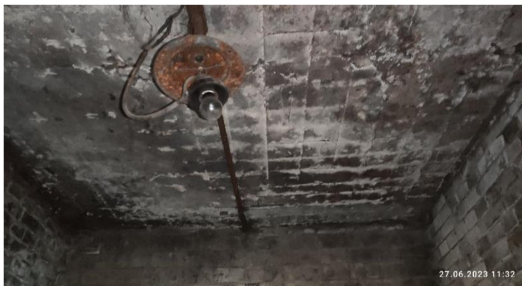
Рис. 83. Прогибы перекрытий, биоповреждение конструкций вследствие течи кровли
