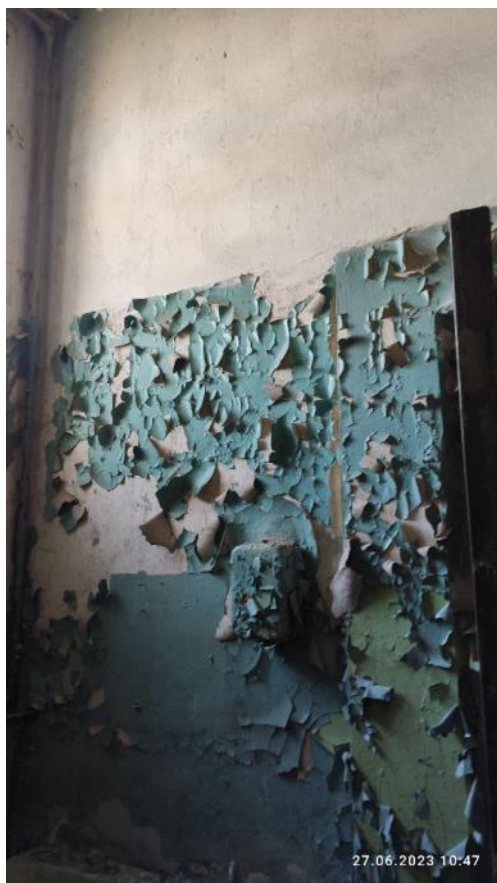
Рис. 148-149. Износ отделочного покрытия стен
