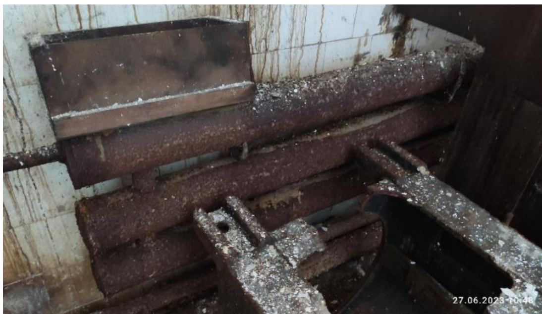
Рис. 173. Значительное поражение коррозией трубопроводов системы отопления
